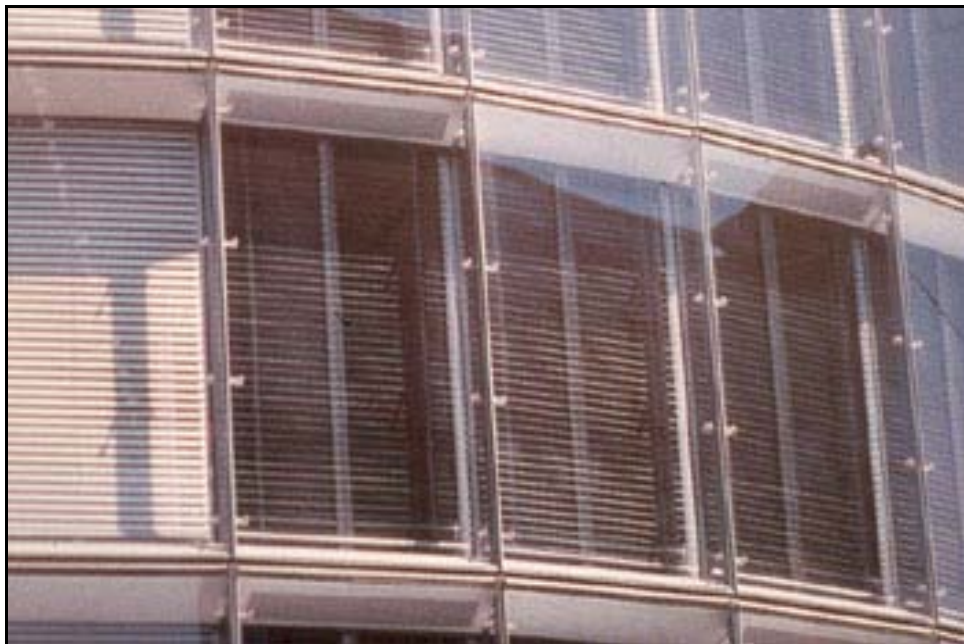
Edificio de la RWE AG en Essen, donde se ve la opción de control solar mediante lamas interiores (persianas).
