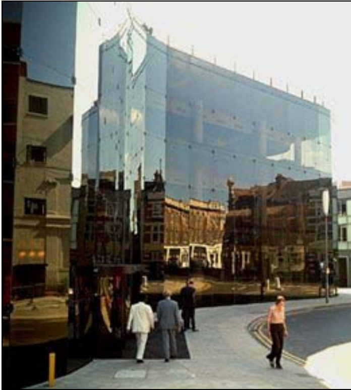
Vista de la fachada de la Willis Faber, N. Foster.
