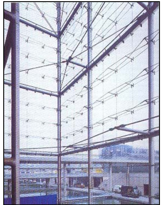
Detalle de la fachada de vidrio.
