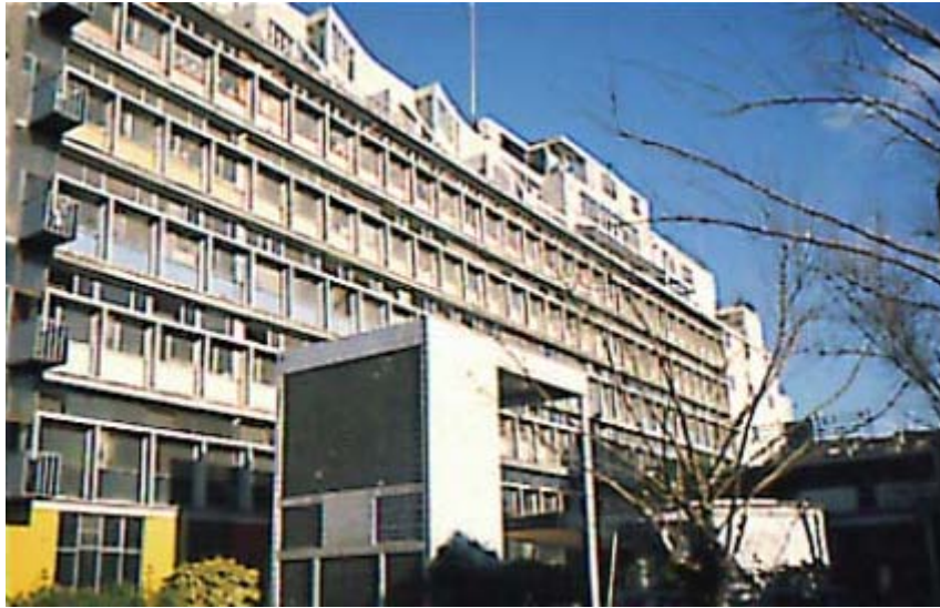
Fachada frontal de la Cité Refuge de Le Corbusier.
