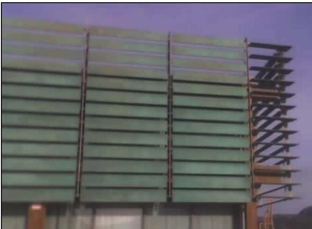
Fachada Principal del Edificio del Real Club de Regatas de Cartagena.
