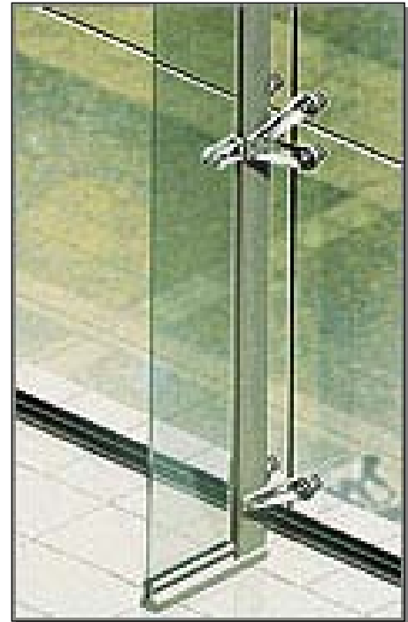
Detalle del contrafuerte de vidrio
