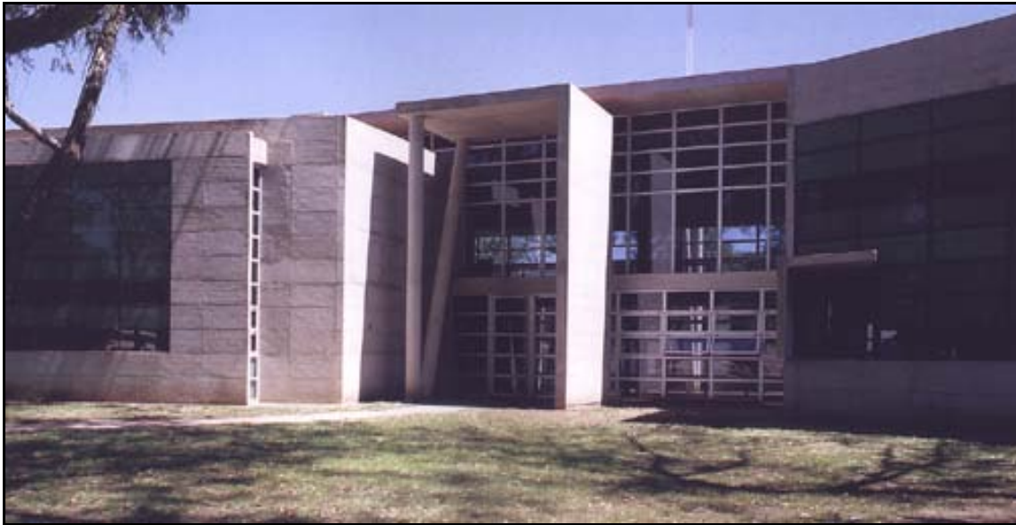
En esta imagen se puede apreciar los parasoles de hormigón, tanto horizontales como verticales que protegen a la fachada acristalada del soleamiento. Edificio sito en el Campus Universitario de Córdoba. Argentina.
