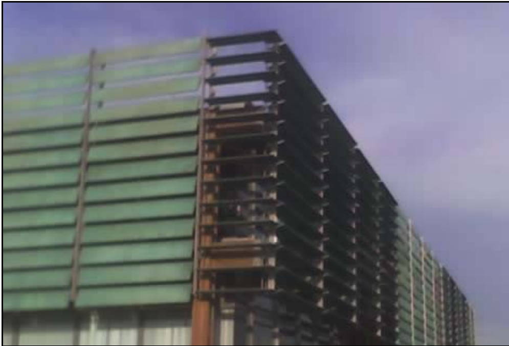
Fachada Sur del Edificio del Real Club de Regatas de Cartagena.
