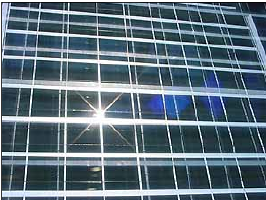
Imagen de la fachada del edificio.
