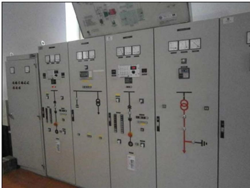
Figura 7.4: Equipo de control de una central hidroeléctrica.
