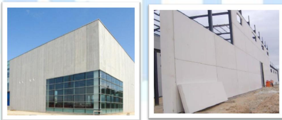
Ilustración 10 fachada de hormigón prefabricado (izquierda), paneles de hormigón prefabricado (derecha)
