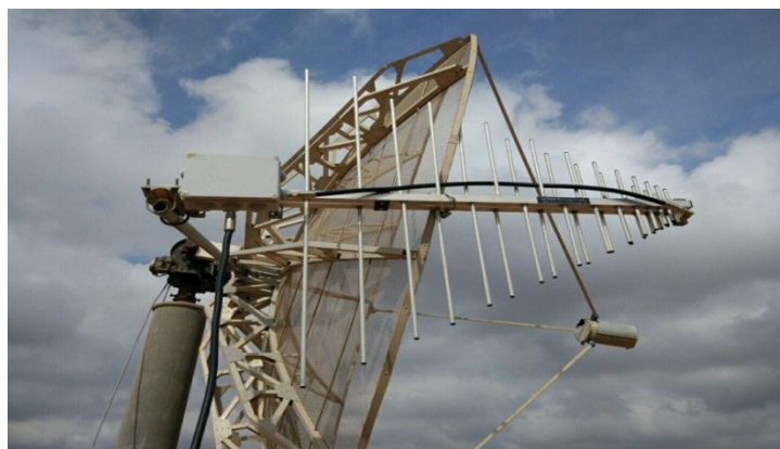
Figura 2.20. Instalación de la caja en la antena.
