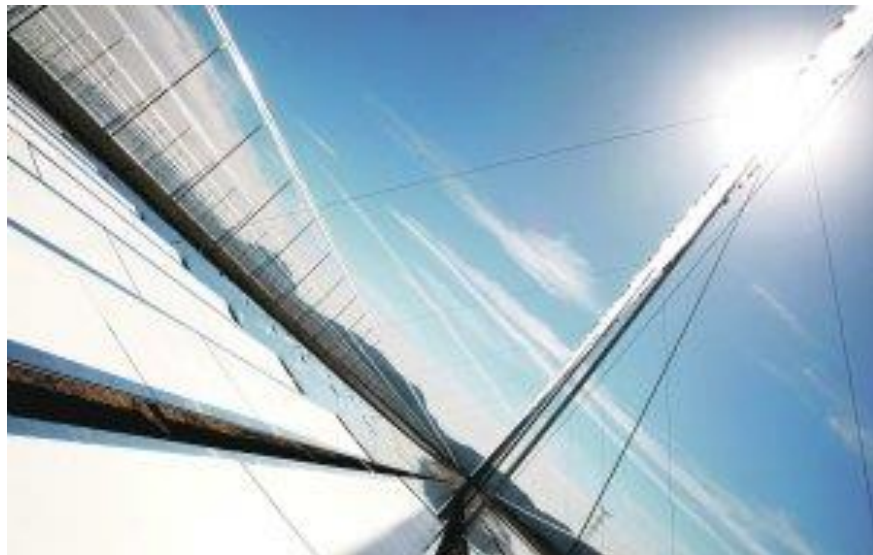
Figura 1.-Planta de energía termosolar con tecnología Fresnel
