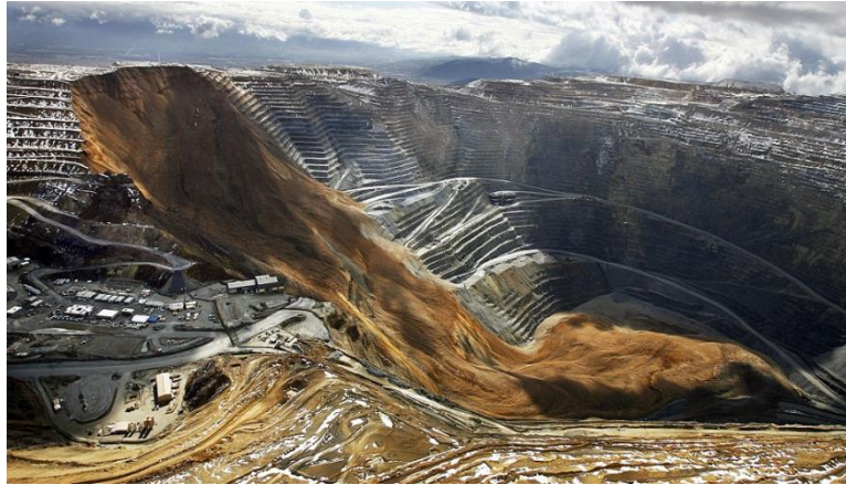
Figura 2.1 Deslizamiento en mina de Cobre de Utah (2013). [Fuente: EnriqueMontalar.com]
