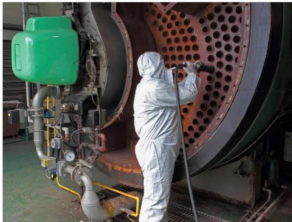
Figura 4.12. Ejemplo de sistema de limpieza mecánica manual. Fuente: (Optimise Heat & Steam, 2017)
