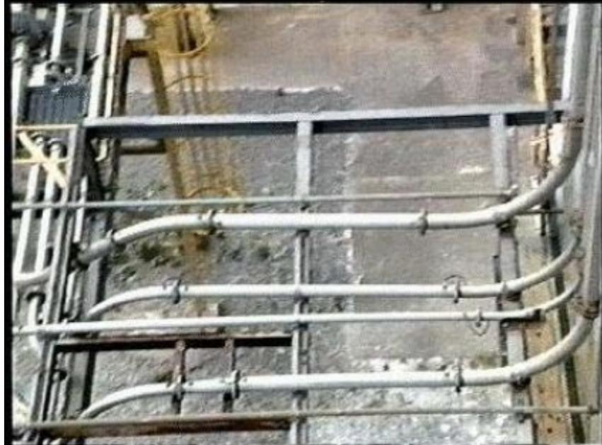
**Figura 48.** Líneas de transporte neumático con codos de gran radio.
