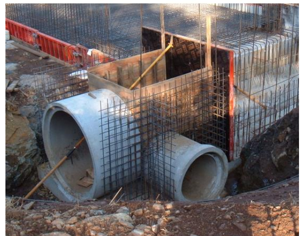
Vertedero Lateral Sección Circular
