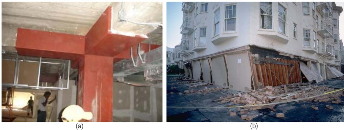
Figura 21: Ejemplo de refuerzo de columna (a). Fallo de un solo piso por sismo (b).
