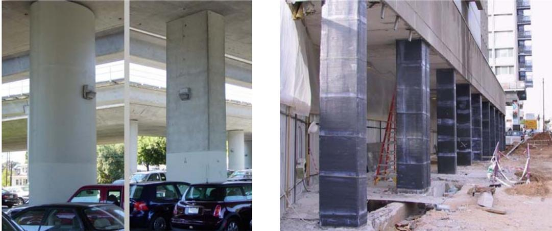
Figura 20: Ejemplos de refuerzo por confinamiento.
