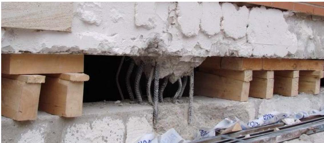
Figura 22: Ejemplo de fallo tipo pilar-corto.
