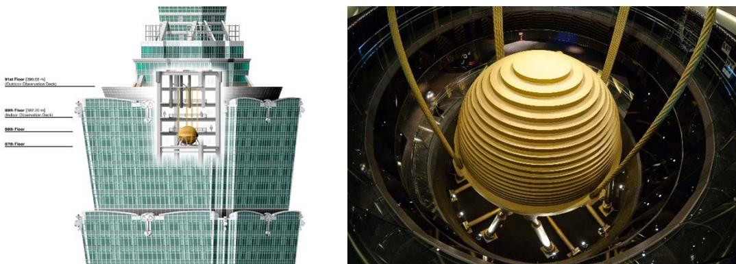
Figura 26: Ejemplo de sistema de disipación de energía.
