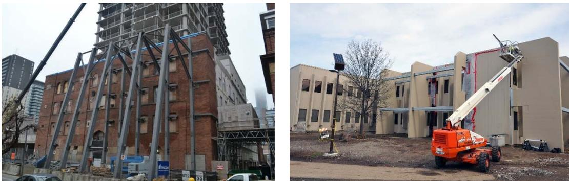
Figura 16: Ejemplos de contrafuertes aplicados a estructuras existentes.
