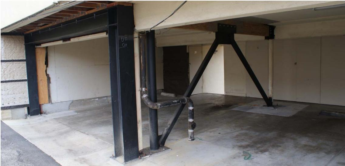
*Figura 17: Ejemplo de marco resistente de momentos aplicado a una estructura existente.*
