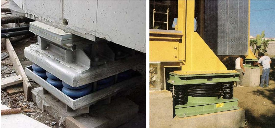
Figura 24: Ejemplo de aislamiento de bases.
