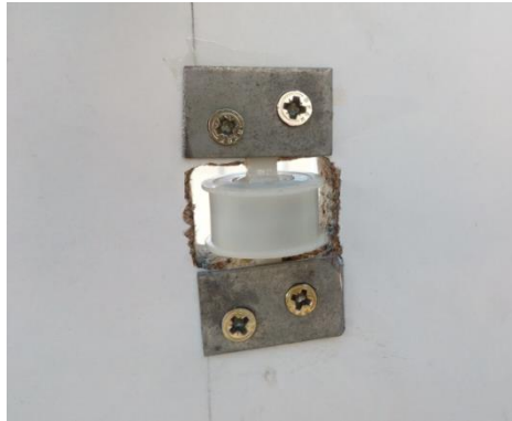
Figura 3.58: Polea asegurada mediante placas metálicas.
