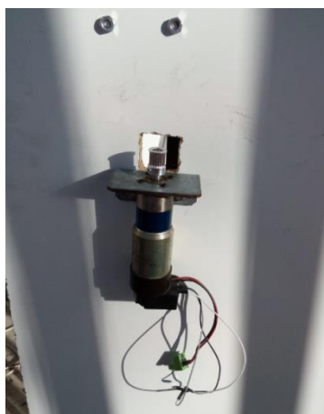
Figura 3.56: Colocación del motor.
