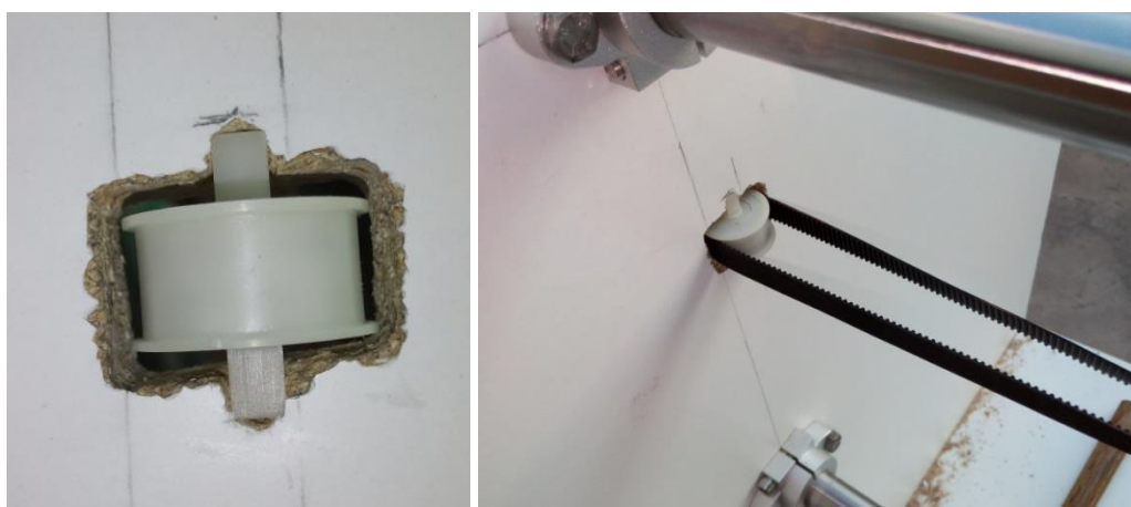
Figura 3.57: Colocación de la polea.
