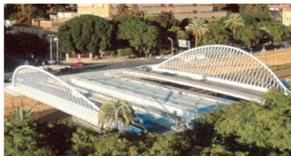
Fig. 2. Puentes gemelos del Hospital General de Murcia.
