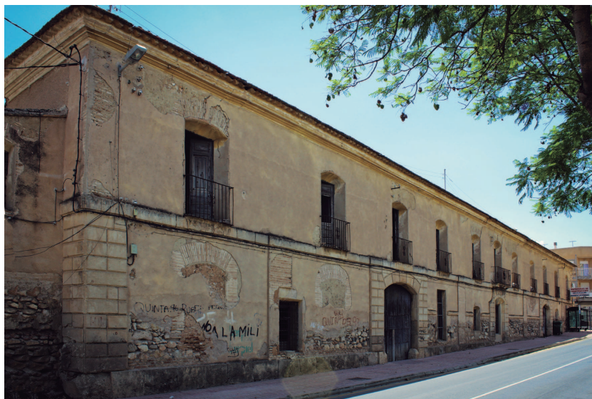
[FIG. 8]. FACHADA PRINCIPAL DE LA POSADA DE LIBRILLA, DONDE SE PUEDE APRECIAR LA JERARQUIZACIÓN DE LOS HUECOS SIMÉTRICOS Y EL USO DE LA SILLERÍA EN LOS DETALLES [ARCHIVO DE LA AUTORA].
