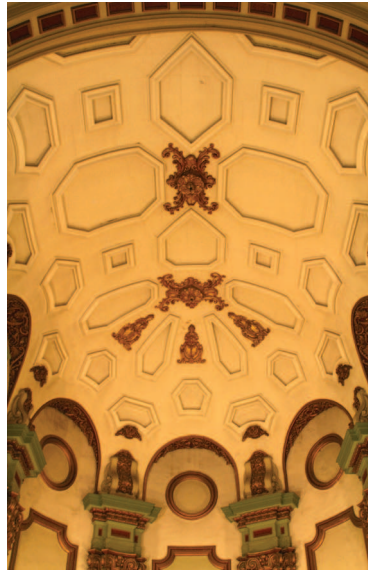
[FIG. 7]. DETALLE ACTUAL DE LA BÓVEDA DEL PRESBITERIO DE LA IGLESIA DE SANTA MARÍA DE GRACIA.
