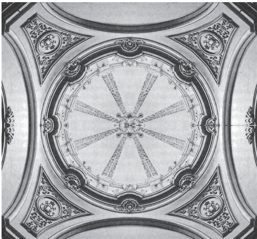
[FIG. 2]. CÚPULA DE LA CAPILLA DE LA COFRADÍA CALIFORNIA EN LA IGLESIA DE SANTA MARÍA DE GRACIA.
