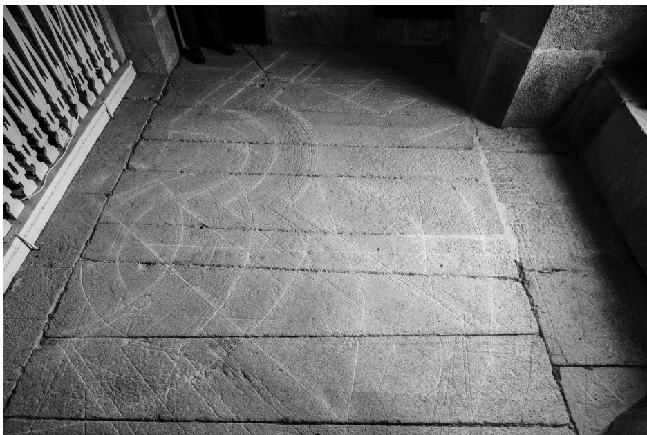
1. Trazados de cantería en el coro alto de la capilla de San Telmo, Tui.
