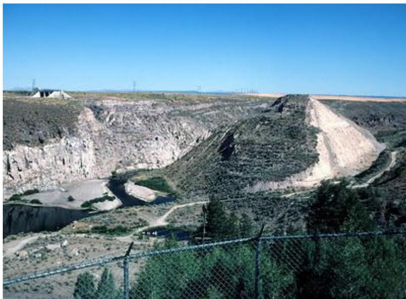
Foto 3 Presa de Teton tras el derrumbe debido a las filtraciones
