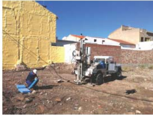
Emplazamiento del sondeo nº1 en el solar objeto del estudio
