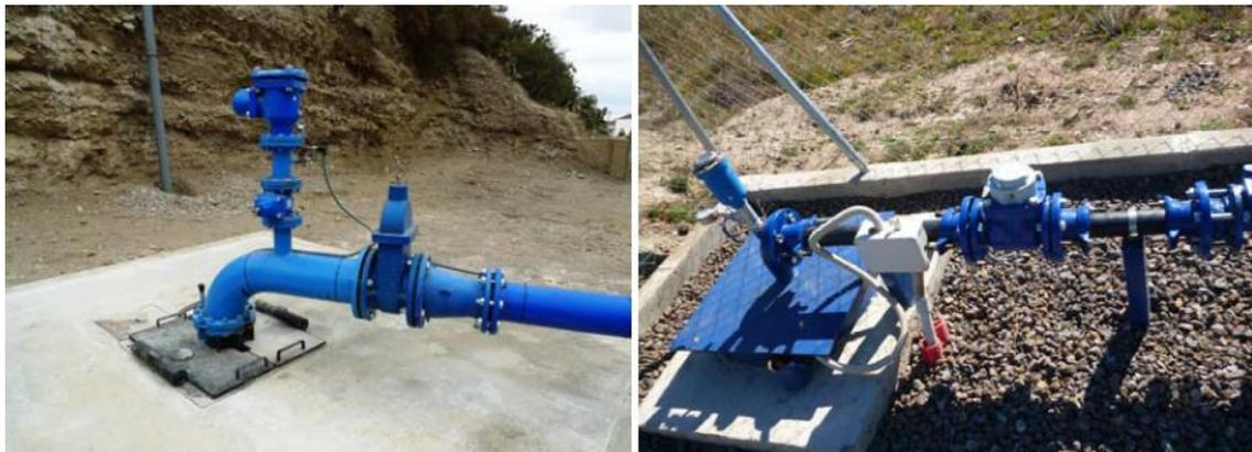
Una vez terminado la perforación del sondeo se montara una arqueta sujeta al emboquille del sondeo con la finalidades anteriormente citadas.
