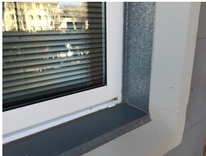
Ilustración 12: Detalle Alfeizar ventana
