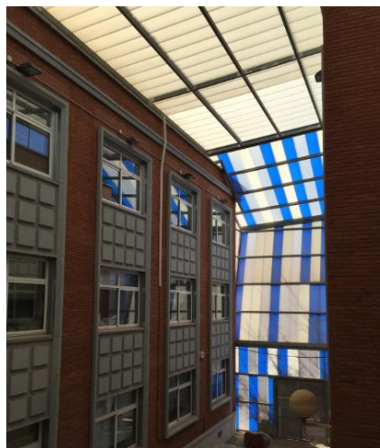
Ilustración 29: Cerramiento singular desde el interior
