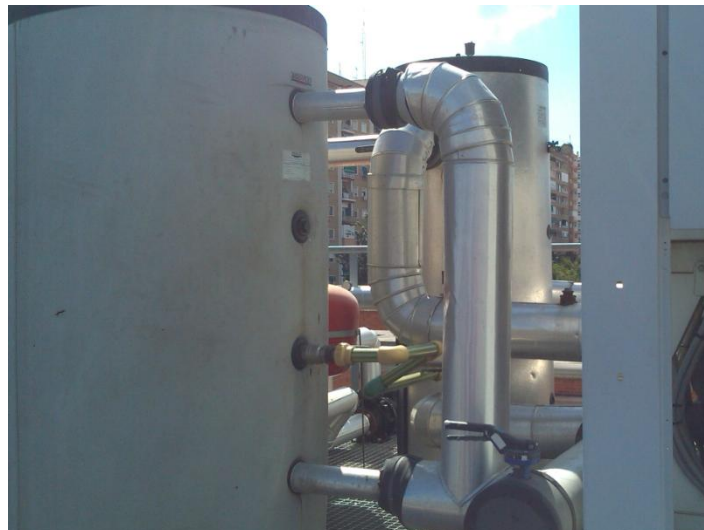
Ilustración 42: Deposito de inercia
