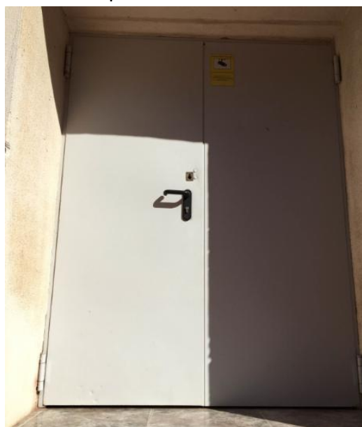
Ilustración 21: Puerta galvanizada gris
