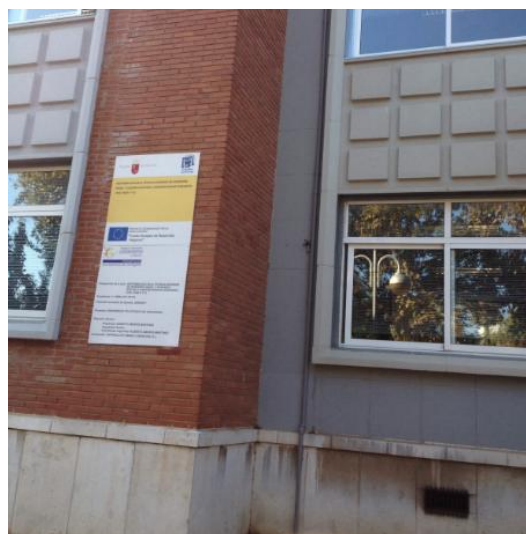
Ilustración 11: Muros exteriores del edificio
