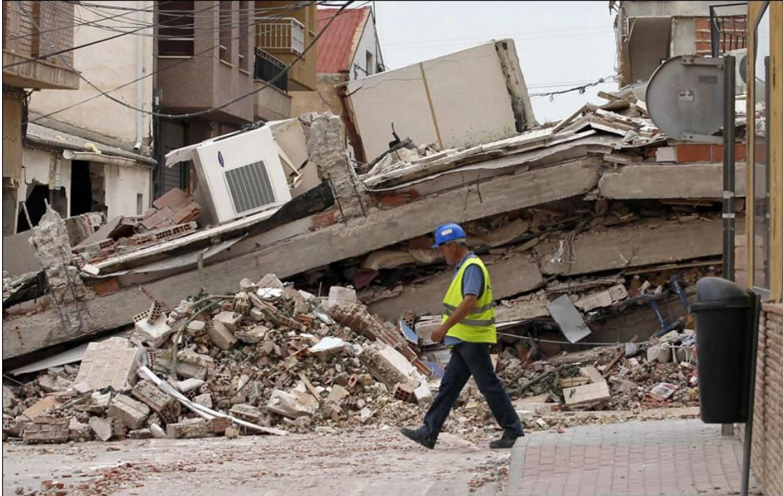
Figura 23: Edificio colapsado durante el terremoto de Lorca.
