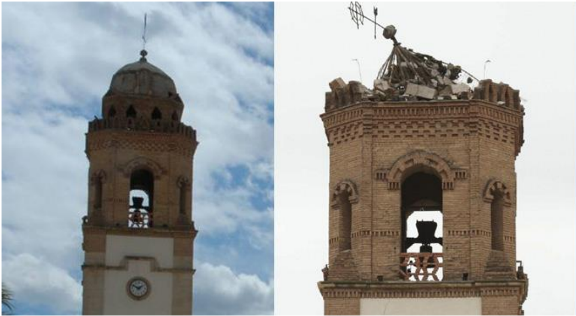
Figura 17: Torre del convento de la Virgen de las Huertas antes y después del terremoto del 2011 ( http://www.patrimonioxlorca.org ).
