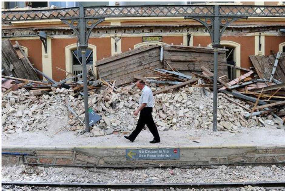
Figura 22: Estación Lorca-Sutullena tras el terremoto de Lorca de 2011 ( http://elpais.com ).
