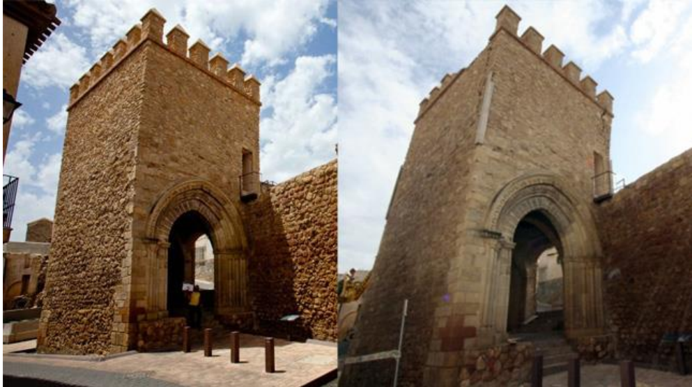
Figura 11: Torre de Porche de San Antonio antes y después del terremoto de Lorca del 2011 ( www.patrimoniolorca.org ).
