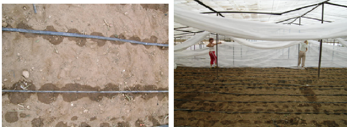
Foto 22. A y b. Comprobación del funcionamiento del sistema de riego. Colocación de plásticos.
