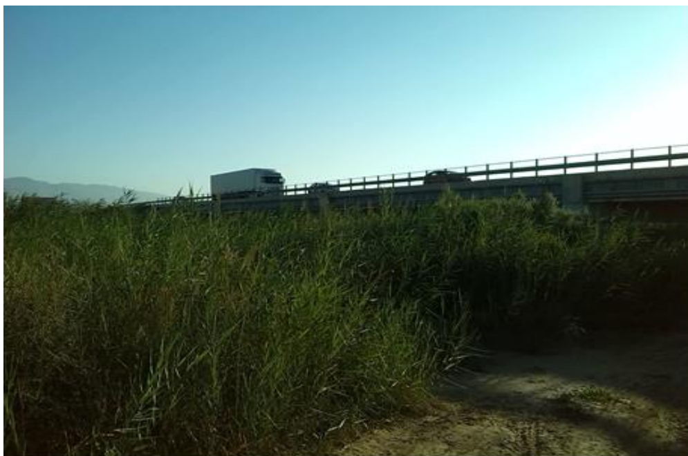
Foto 1. Vista aguas arriba del puente en la carretera de conexión Las Marinas - Puerto Rey
