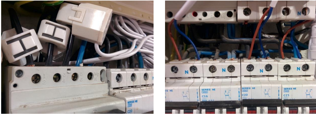
Figura 77. Detalles de la instalación del contador Z-Wave
