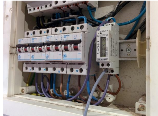
Figura 72. Instalación de medidor monofásico Voltcraft
