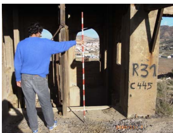
Foto 2.5. Pozo 52-C445. Comunica por un túnel situado 20 m más bajo.
