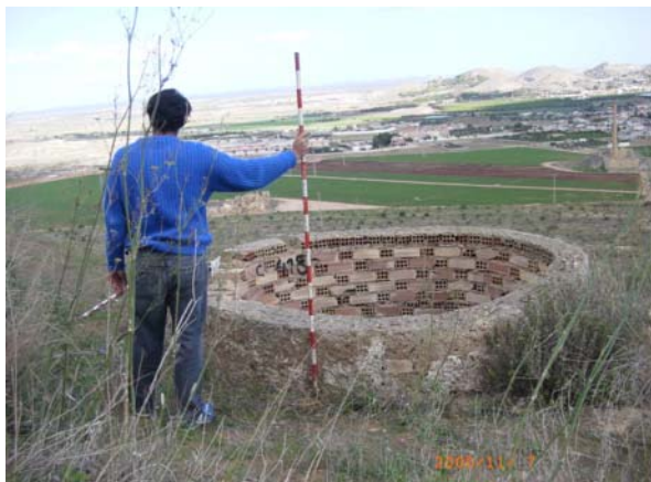
Foto 2.1. Pozo 38-C418. El brocal está roto por uno de los bordes. En general es muy bajo. Es peligroso.
