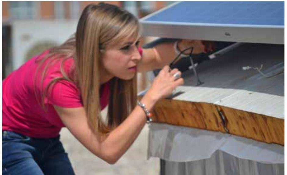
5 y 6 grados la temperatura del panel y aumenta su rendimiento entre un 0,6 y un 1,5%. Mayores mejoras en la producción, de hasta el 5%, se consiguen con ventilación inducida, que sólo es económicamente viable "si aprovecha flujos de aire ya existentes en las instala-
