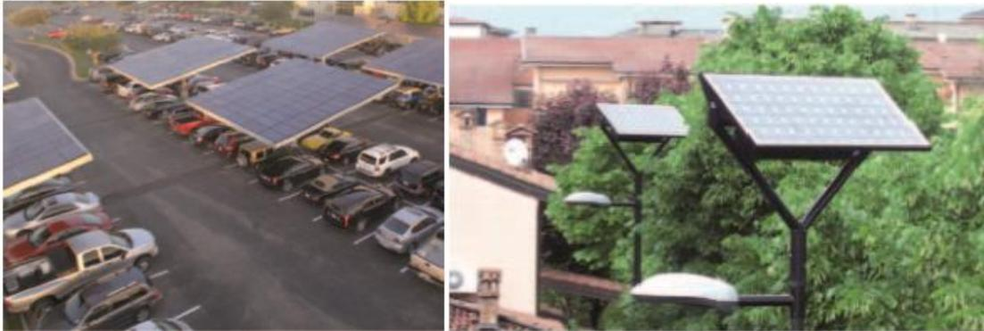
Figura 55 - Cubiertas fotovoltaicas y farolas alimentadas con energía fotovoltaica
