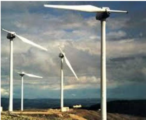
Figura 36 – aerogenerador 1 pala
