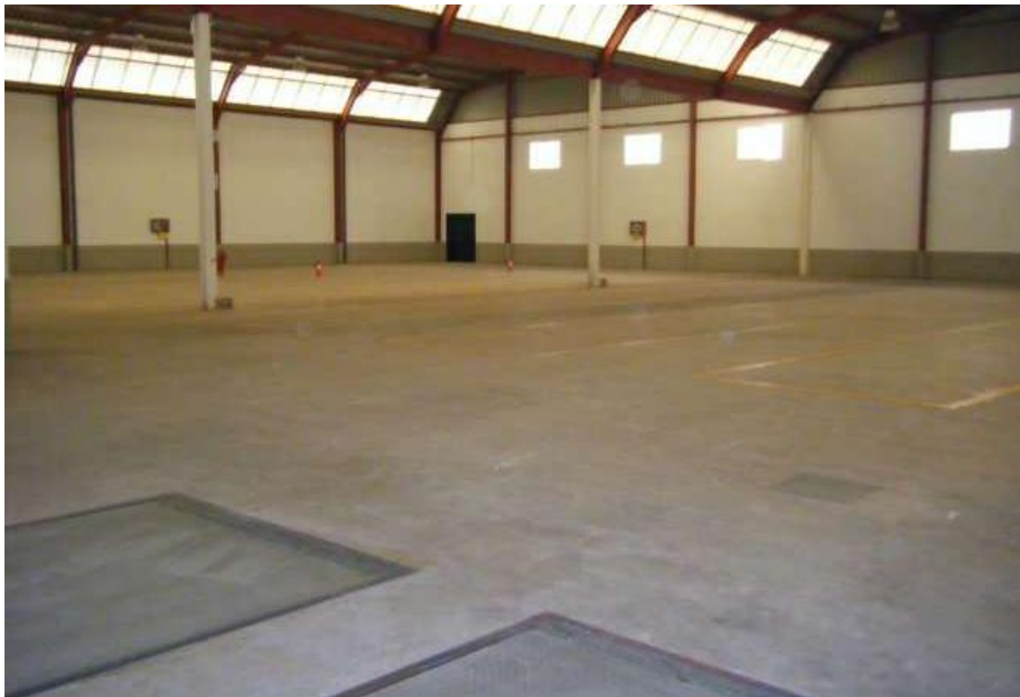
Ilustración 19: Interior de la nave industrial
