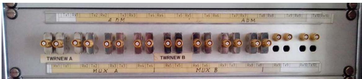
Figura 16 Panel cross-conexiones
