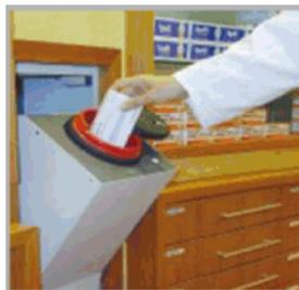
Figura 24. Ejemplo de correo neumático
