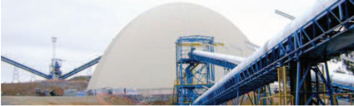
Figura 2. Uno de los domos para pilas de almacenamiento de Aguas Teñidas con fajas transportadoras
