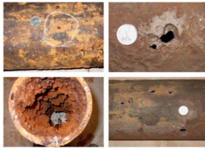
Figura 3.9: Tubería con Corrosión
