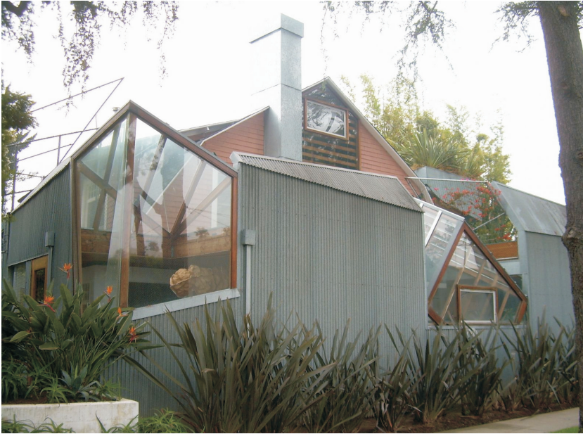
FIGURA 9. ESTA ERA, ANTES DE LA OPERACIÓN LLEVADA A CABO POR GERHY, UNA CASA TRADICIONAL AMERICANA. SIN EMBARGO, TRAS LA REMODELACIÓN, NO SÓLO DESAPARECE EL CONCEPTO FORMAL Y TRADICIONAL DE CASA, SINO QUE QUEDA INHABILITADA LA POSIBILIDAD DE ALCANZAR LA REFERENCIA A ALGO MÁS QUE A SÍ MISMA. LA DES-FAMILIARIZACIÓN ES MANIFIESTA.
