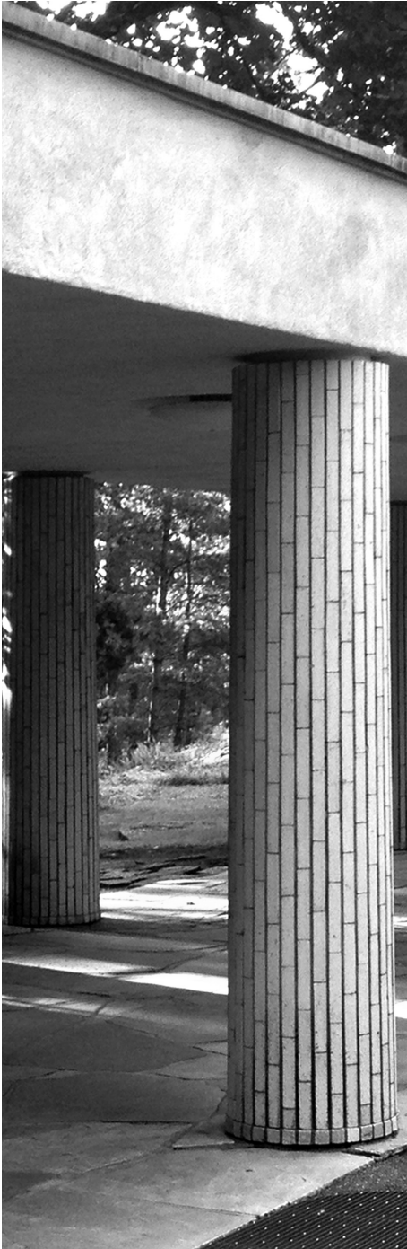
DETALLE DEL SOPORTE, CAPILLA DE LA RESURRECCIÓN, TURKU, FINLANDIA (1891-1955). ARQUITECTO, ERIK BRYGGMAN.
