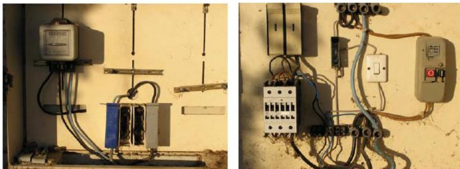
Fotografía tomada en un CM que no cumple con REBT, con alta peligrosidad para las personas.
