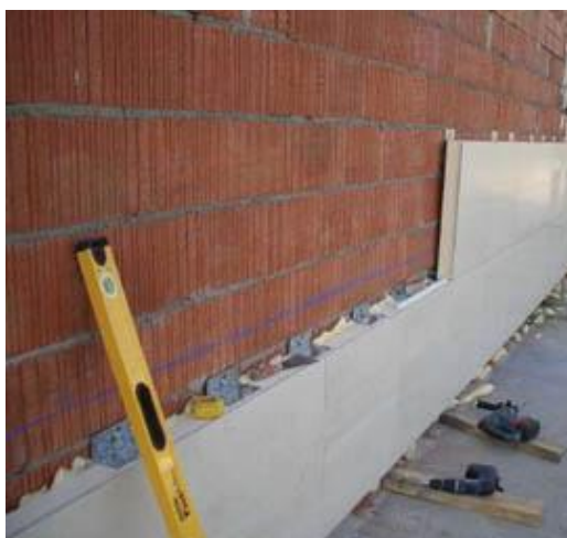
Ilustración 26. Esquema de instalación de aislamiento por el exterior de fachada con XPS
