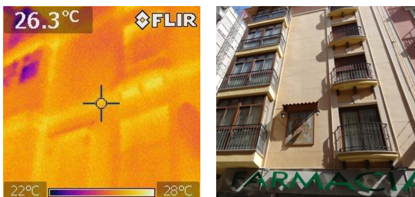
Ilustración 105. Imagen termográfica de la fachada principal del Edificio Santa María a las 08:00.
