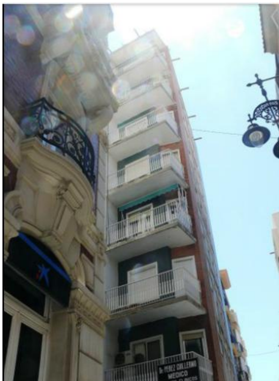
Ilustración 49. Edificio de Viviendas de Protección Oficial de 1964.
