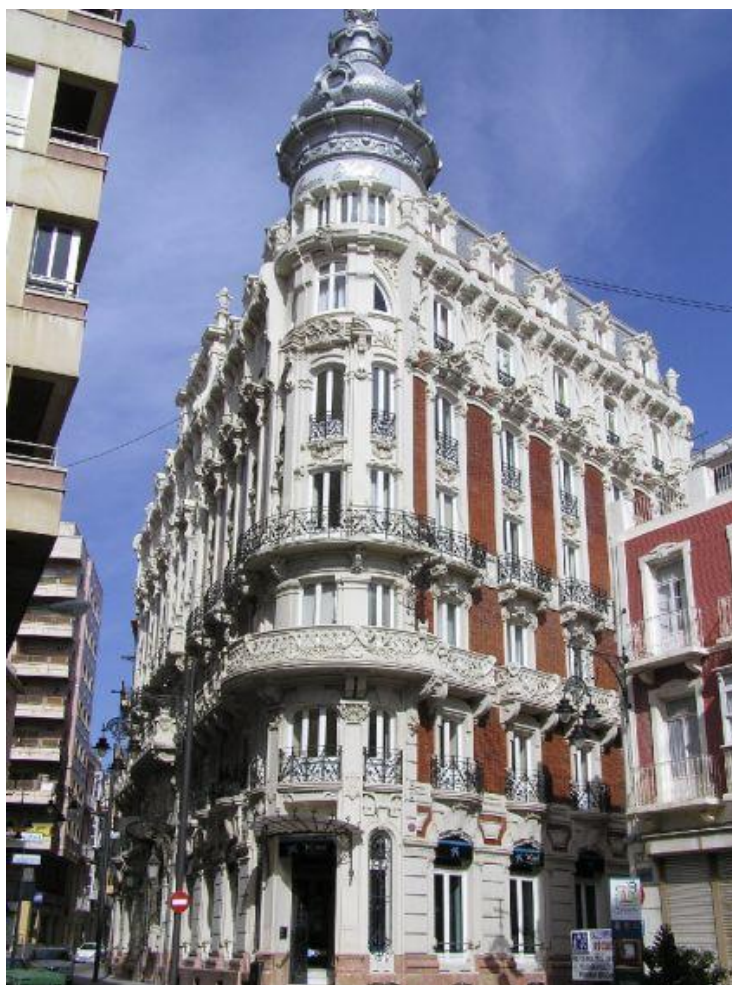
Ilustración 48. Edificio del Gran Hotel, Cartagena.
