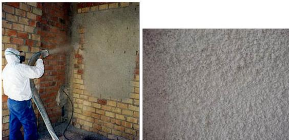
Ilustración 29. Proyectado de lana mineral en el interior de la edificación.
