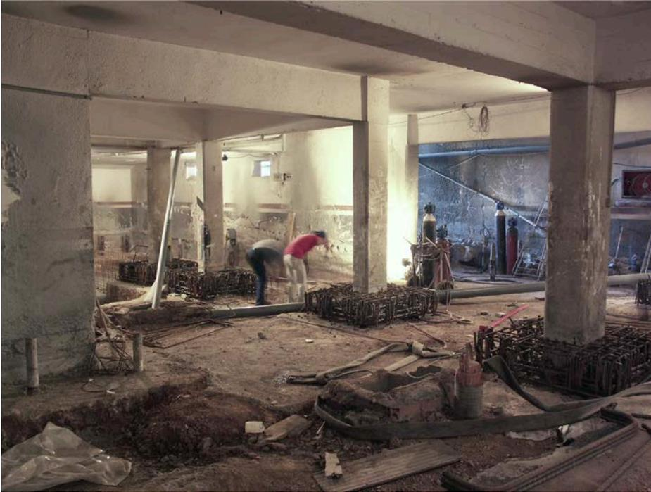
**-FOTO 5. FOTOGRAFÍA GENERAL DEL SÓTANO EN LA QUE SE ESTÁ EJECUTANDO EL ARMADO DE LOS ENCEPADOS DE UNION DE LOS MICROPILOTES CON LA CIMENTACIÓN. (Fotografía del Autor)**
