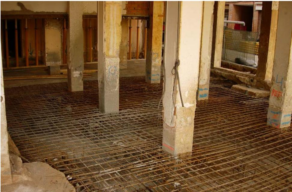
**-FOTO 6. FOTOGRAFÍA DEL ARMADO DE LA LOSA QUE VA A SERVIR DE UNIÓN ENTRE LOS MICROPILOTES Y LA CIMENTACIÓN. EN LA QUE TAMBIEN SE PUEDE APRECIAR AL FONDO DE LA FOTOGRAFÍA, EL APUNTALAMIENTO DE PARTE DEL EDIFICIO. (Fotografía del Autor)**
