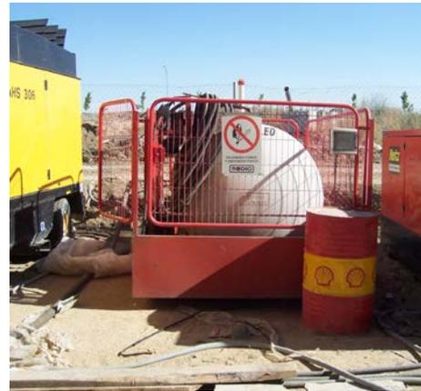
**Foto.- 8.15** Fotografía de los generadores eléctricos situados en el exterior de la obra necesarios para dar servicio a la maquinaria. Así como un depósito de combustible para abastecer los generadores. *(Foto del Autor)*
