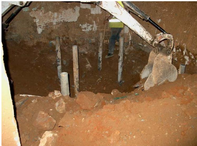
**Foto.- 8.10.Fotografía de una mini-excavadora trabajando en el descubrimiento de la cimentación. (Foto del Autor)**
