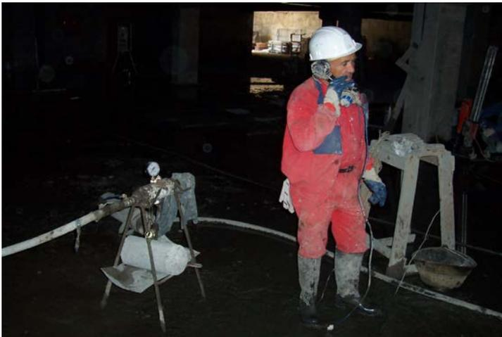
**Fotos.- 8.21.** En esta fotografía se ve el manómetro que sirve para controlar la presión de inyección, así como el oficial en perfecta comunicación, a través del genófono, con el operario del panel de control de la planta de fabricación de lechada. *(Foto del Autor)*
