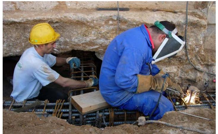
**Fotos.- 8.22. Fotografías del armado necesario para unir la cimentación con los micropilotes cuando se trata de recalces de forma indirecta. Y en la que se puede ver a dos operarios realizando dicho armado. (Foto del Autor)**
