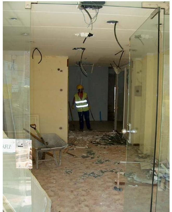
**Fotos.- 8.2. Fotos de los derribos de partes interiores del edificio, necesarios en muchas ocasiones debido a la dificultad de acceso de la maquinaria a utilizar, para los trabajos de perforación. (Foto del Autor)**
