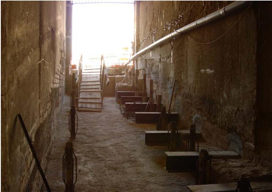
**-FOTO 3. FOTOGRAFÍA DE UNA CIMENTACIÓN DEL BARRIO DE EL CARMEL(BARCELONA) EN PROCESO RECALCE, EN LA QUE SE PUDEN VER LOS MICROPILOTES YA EJECUTADOS ASI COMO LOS PERFILES (HEB) DE UNIÓN DE LA CIMENTACIÓN CON LOS MICROPILOTES, A FALTE DE EJECUTAR EL ENCEPADO DE UNIÓN. (Fotografía del Autor)**
