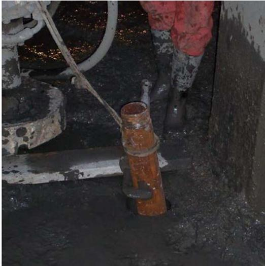
**Foto.- 8.20. En la fotografía se ve el método de sujeción que utilizan para evitar que la armadura se cuele dentro de la perforación mientras esperan que el otro tramo sea enroscado. (Foto del Autor)**
