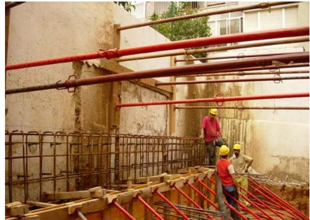
**Foto.- 8.28.** Fotografía un muro auxiliar de contención. Trabajo que corresponde con los muchos que hay que realizar dentro de la restauración de la zona afectada. *(Foto del Autor)*
