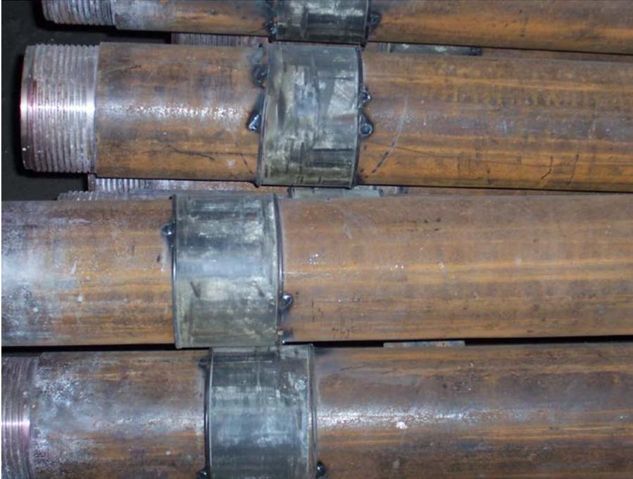
**-FOTO 7. FOTOGRAFÍA DE LA ARMADURA TUBULAR UTILIZADA EN LOS MICROPILOTES EN LA QUE SE VE EL DETALLE DEL MANGUITO, FORMADO POR UNA BANDA DE NEOPRENO, POR DONDE SANDRÁ LA LECHADA EN EL MOMENTO DE LA INYECCIÓN. (Fotografía del Autor)**
