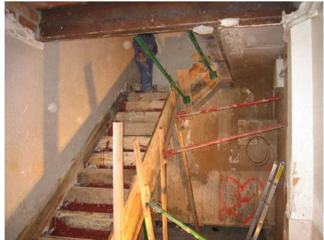
**Fotos.- 8.26.**Fotografías de la reposición de escaleras que tuvieron que ser demolidas en el comienzo de las obras para lograr el acceso de la maquinaria *(Foto del Autor)*
