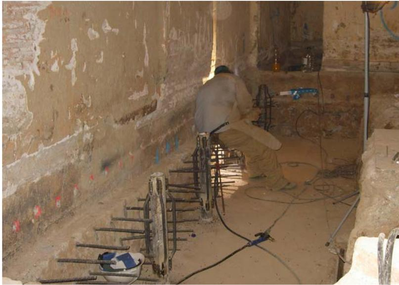
**Foto. 6.8** -Foto en la que se observa las barras de acero ancladas, en este caso, a una zapata corrida bajo un muro. Y en la que se ven también la cabeza de los micropilotes que posteriormente serán unidos a las barras con un encepado, como se observa en el detalle anterior. *(Fuente Autor)*
