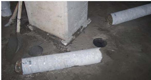
**Foto.- 8.13.En esta otra fotografía se observa la parte de cimentación ya perforada, y como el taladro que queda sirve de de una perfecta guía para iniciar la perforación de terreno. (Foto del Autor)**
