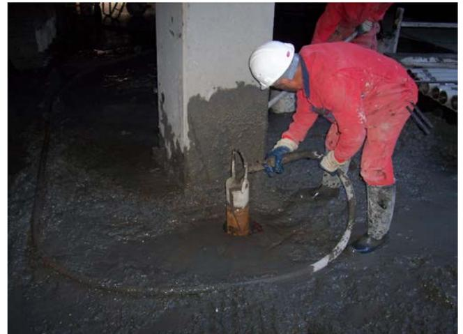
**Foto.- 8.21.** En la fotografía superior se encuentra un operario conectando la manguera de inyección en el micropilote. *(Foto del Autor)*
