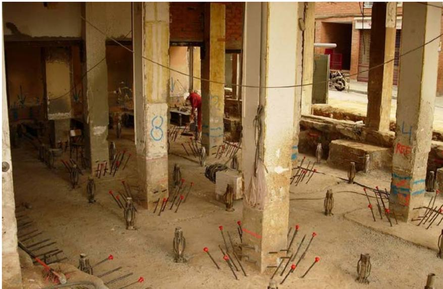
**Foto. 6.9** -Foto de la vista general de la cimentación, en la que se observan ya todos los micropilotes ejecutados y las barras de anclaje a las zapatas y muros, a falta de colocar la armadura que formará en el encepado. *(Fuente Autor)*
