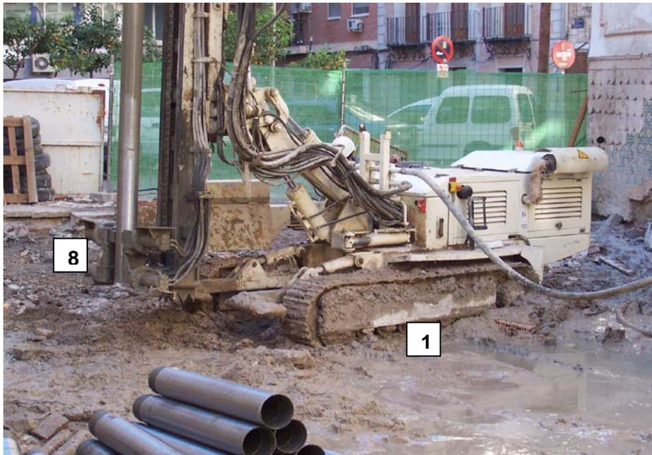
Foto 6.5 – Otro ejemplo típico de máquina para micropilotar. *Fotografía del autor*
