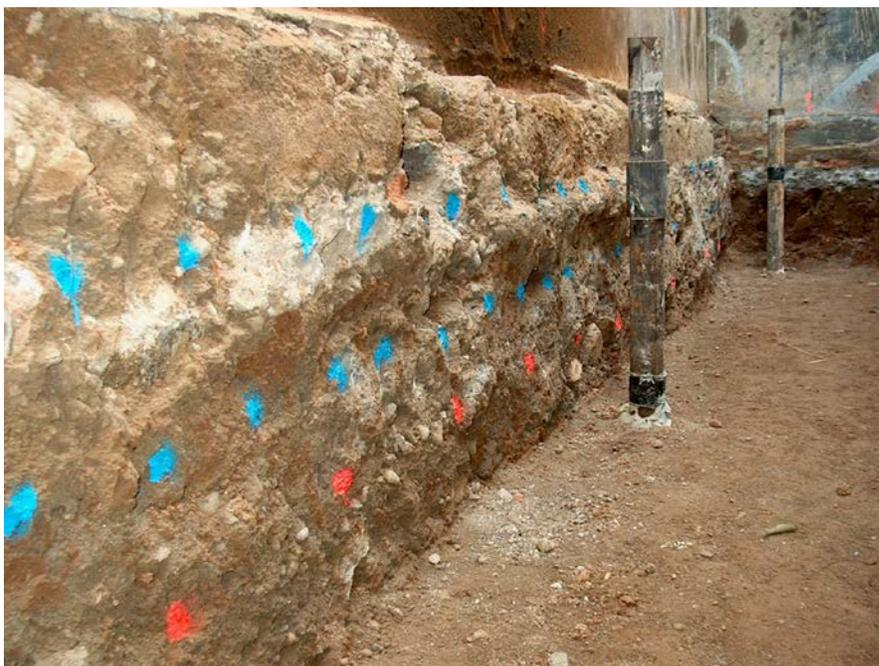
**-FOTO 4. FOTOGRAFÍA EN LA QUE SE OBSERVA LOS PUNTOS REPLANTEADOS PARA EL ANCLAJE EN LA CIMENTACIÓN DE LAS BARRAS DE ACERO TIPO GEWI. (Fotografía del Autor)**
