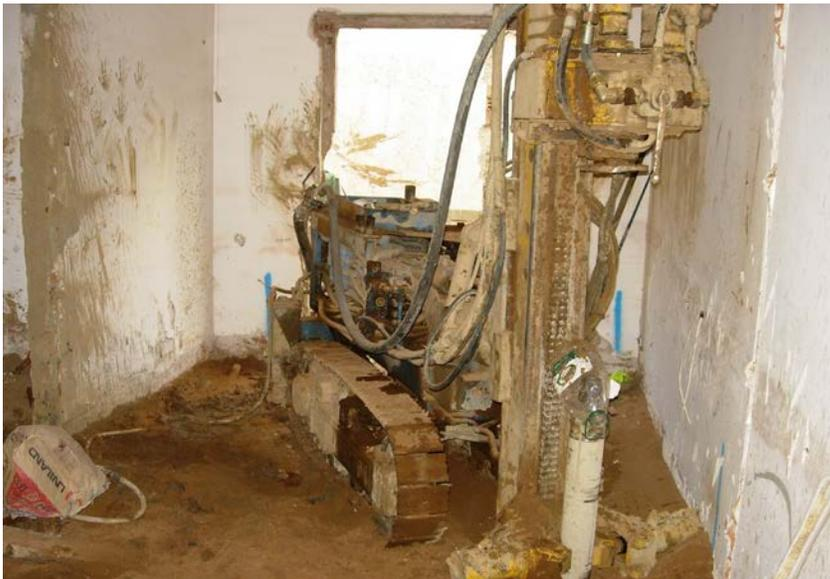
**-FOTO 2.** FOTO DE OTRA MÁQUINA DE SIMILARES CARACTERÍSTICAS UTILIZADA EN LA EJECUCIÓN DE LOS MICROPILOTES PARA RECÁLCE, TRABAJANDO BAJO UN SÓTANO EN UN EDIFICIO DE EL
