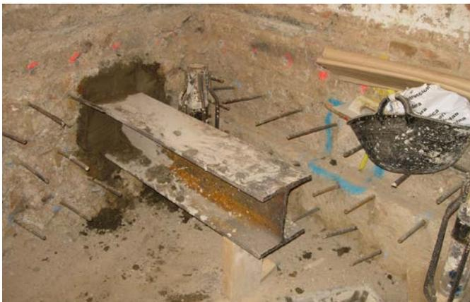
**Foto. 6.10 –Foto en la que se puede observar la ejecución de lo representado en el detalle anterior y en la que se ve claramente el perfil de acero utilizado.**
