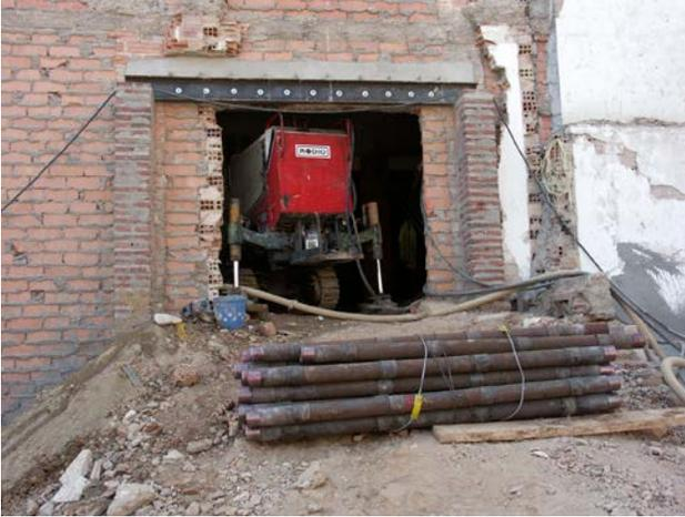
**Foto.- 8.14.**Fotografía de detalle de cómo se introduce la maquinaria a través de un hueco abierto en fachada, así como de los materiales necesarios. *(Foto del Autor)*
