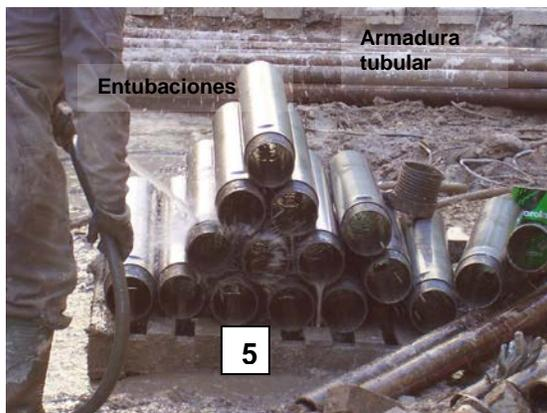
Foto 6.3 – Armadura tubular y entubaciones
