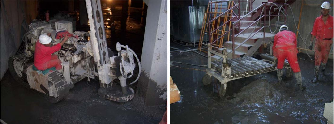
**Fotos.- 8.17.** En la fotografía de la izquierda se ve como la máquina de perforación está trabajando, y a la derecha se encuentran dos operarios sirviendo de tramos de varilla de perforación para lograr la profundidad deseada. *(Foto del Autor)*
