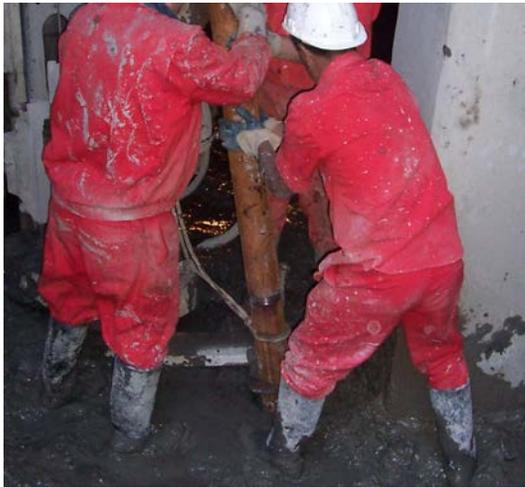
**Foto.- 8.18.** En la fotografía se encuentran tres operarios enroscando los tramos de armadura tubular. (Foto del Autor)
