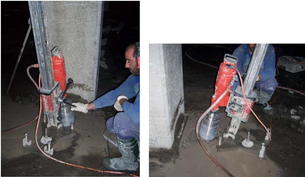
**Fotos.- 8.12 .En esta dos fotografías se ve como se está realizando la perforación de la cimentación existente mediante una máquina de perforación de pequeñas dimensiones, lo cual es muy recomendable debido a una mayor precisión en la perforación inicial. (Foto del Autor)**
