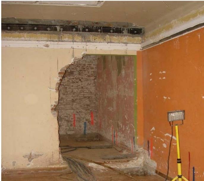
**Foto.- 8.3. Foto de las estructuras provisionales que hay que colocar para poder conseguir ampliaciones de paso. (Foto del Autor)**
