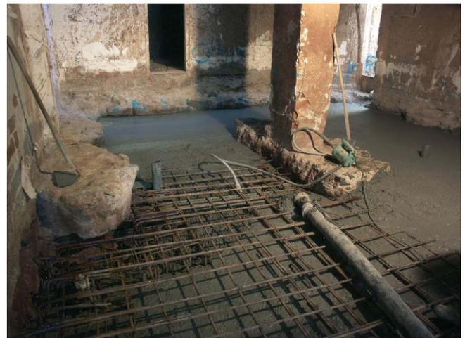
**Fotos.- 8.25.Fotografías de la fase de hormigonado mediante una bomba, en la cual se puede ver las dificultades que se encuentran para poder acceder a determinados lugares.**
