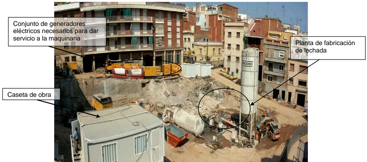
**Foto.- 8.7. Foto de la vista general de maquinaria y medios auxiliares necesarios para la realizaci3n de una obra de recalce mediante micropilotaje. (Foto del Autor)**
