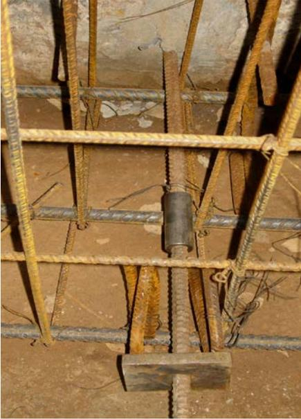
**Foto.- 8.23. Fotografía de una barra tipo Gewi muy utilizada en los recalces de forma indirecta.**
