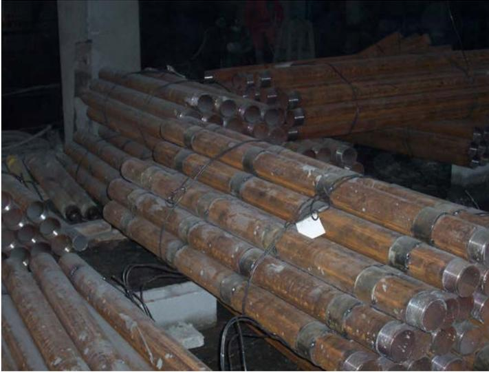
**Foto.- 8.8.** Foto del almacenamiento de la armadura tubular de los micropilotes, en la que como se puede apreciar en la fotografía cada tipo de armadura se encuentra adujada perfectamente en lotes y con un identificador. *(Foto del Autor)*
