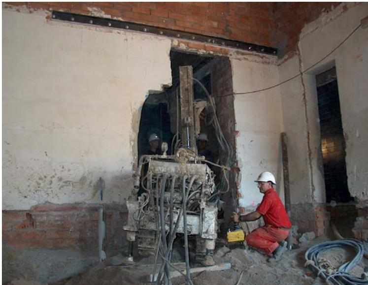
**Foto.- 8.6. Foto de las dificultades que tiene la maquinaria para el acceso al lugar de trabajo, lo cual hace necesario la construcción de estas estructuras provisionales para poder abrir huecos en distintas partes del edificio (Foto del Autor)**
