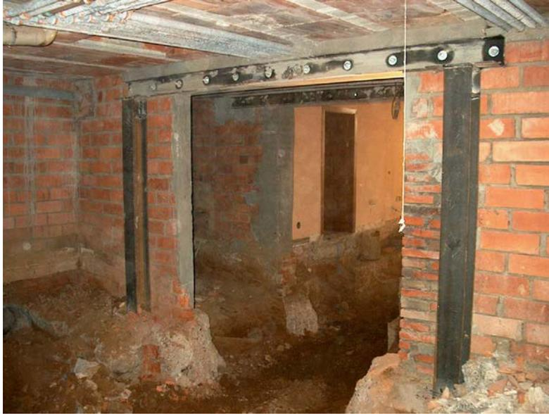
**Foto.- 8.5. Foto del detalle de una estructura provisional necesaria para aberturas especiales. (Foto del Autor)**
