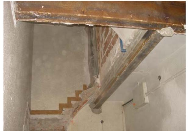
**Foto.- 8.4. Foto de una estructura provisional, colocada para poder demoler una escalera, circunstancia habitual para poder lograr el acceso de la maquinaria necesaria para los trabajos de recalce. (Foto del Autor)**
