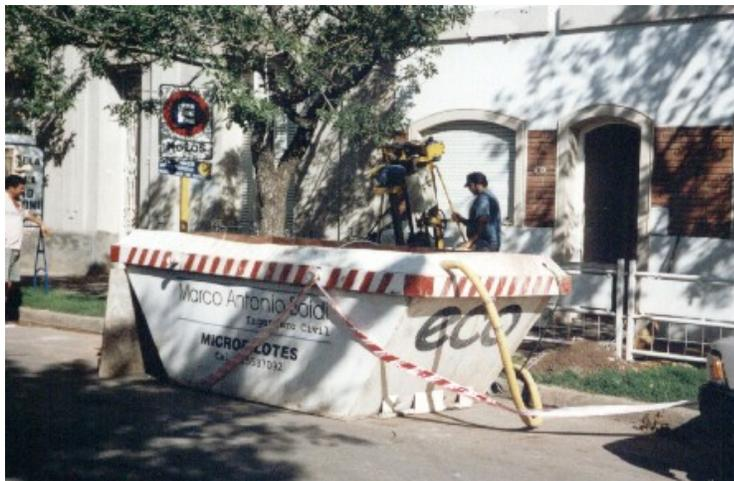
**Foto 6.1 – Foto en la que está procediendo al recalce de una cimentación mediante micropilotes, y en la que aparece en primer plano, el contenedor utilizado como depósito de agua necesaria (en la algunas ocasiones) para la perforación. Fotografía del autor**
