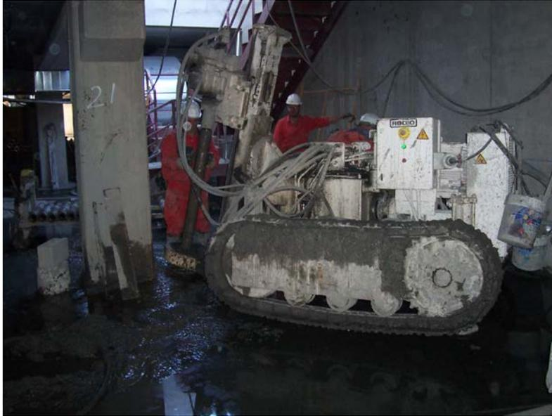
**-FOTO 1.** FOTO DE LA MÁQUINA UTILIZADA EN LA EJECUCIÓN DE LOS MICROPILOTES PARA RECÁLCE, TRABAJANDO EN EL SÓTANO DE UNA NAVE INDUSTRIAL EN VILLAVERDE (MADRID)
