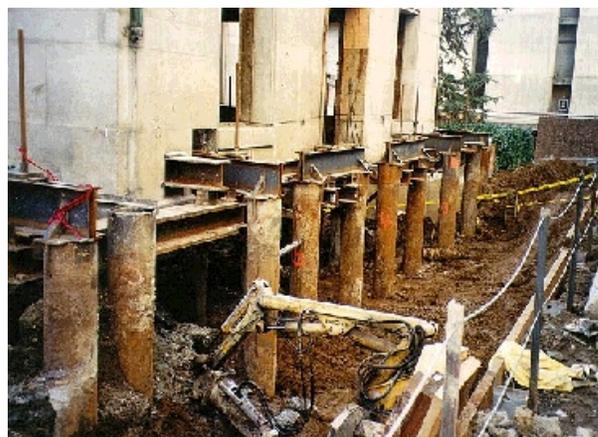
**Foto. 6.11** Recalce de edificio pilotado, en la que se puede ver la vigas metálicas utilizadas para poder transferir las cargas a los encepados. *Fotografía facilitada por PIRESA*
