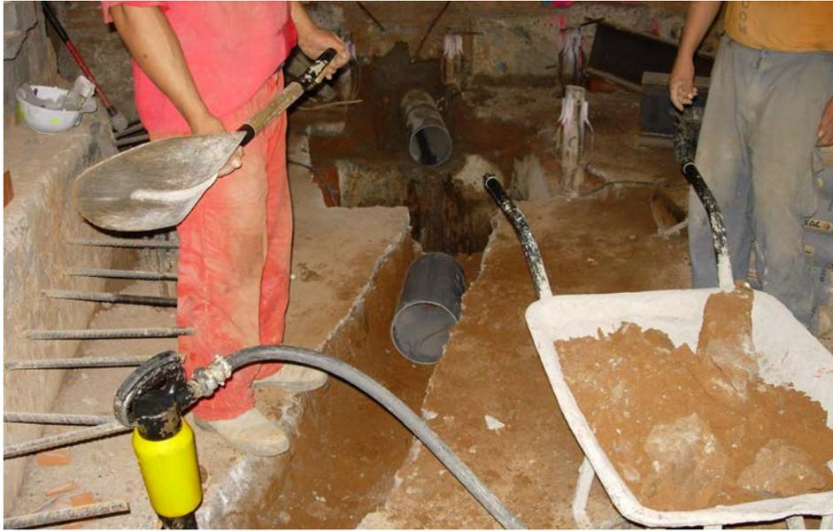
**Foto.- 8.11.**En esta fotografía se puede observar como en muchas ocasiones se tienen que realizar las excavaciones de forma manual debido a la imposibilidad de acceso de algún tipo de maquinaria de excavación. *(Foto del Autor)*
