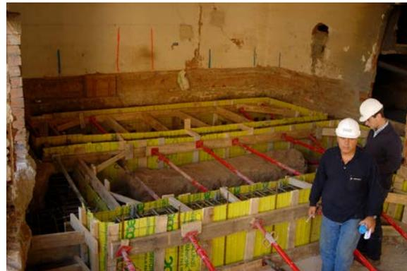
**Fotos.- 8.24. Fotografías del encofrado necesario para formar los enlaces entre los micropilotes y la cimentación preexistente. (Foto del Autor)**
