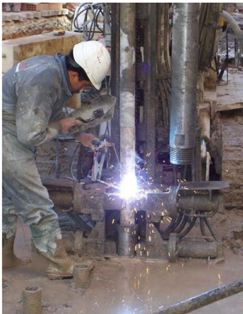
**Foto.- 8.19.** En la fotografía se observa un operario realizando la soldadura de unión de tramos de armadura tubular, en la que se puede apreciar el peligro que conlleva debido a las condiciones en que se realiza. (Foto del Autor)
