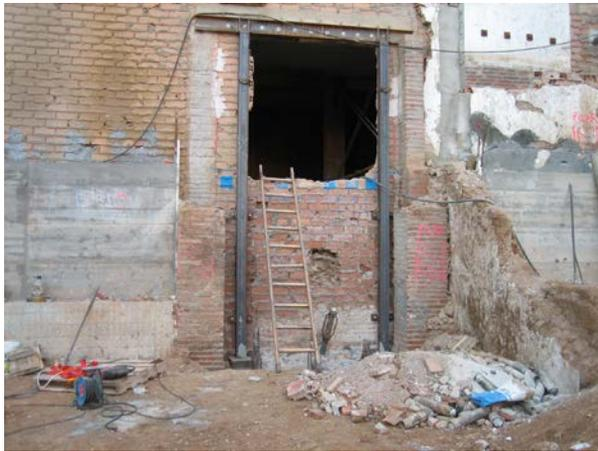
**Foto.- 8.27.**Fotografía de uno de los huecos abiertos en fachada que tienen que ser tapados. *(Foto del Autor)*
