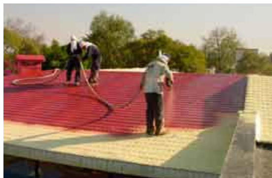
Ilustración 23. Aislamiento por el exterior sobre teja.
