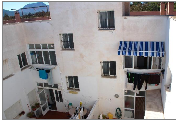
Fachada este del patio interior central
