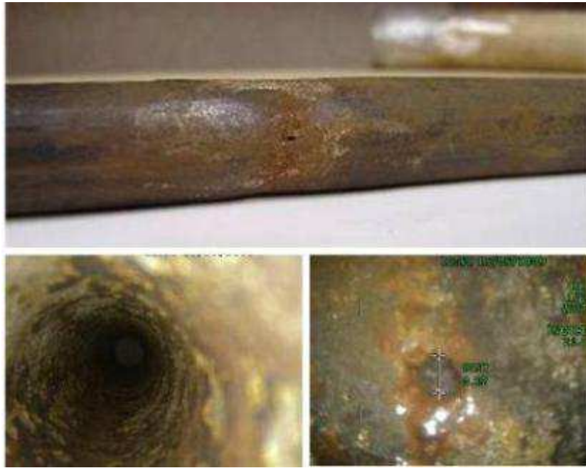
Figura 14 Corrosión por pitting
