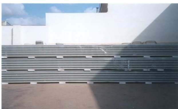
Imagen 4.6.5. Recepción de los paneles. Máximo tres alturas interponiendo tacos de pórex. Detalle ampliado de la colocación de los tacos de pórex.
