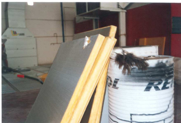
Imagen 5.3.3. Panel aislante empleado para ejecutar el falso techo..
