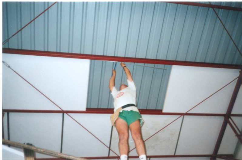
Imagen 5.2.2. Corte del perfil metálico en C en el lateral de la correa.
