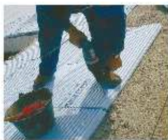
Imágenes 5.1.1. y 5.1.2.- Instalación de planchas de XPS sobre faldones de cubiertas inclinadas 1 .
