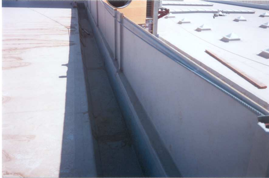
Imagen A.4.5. Detalle de la canal.
