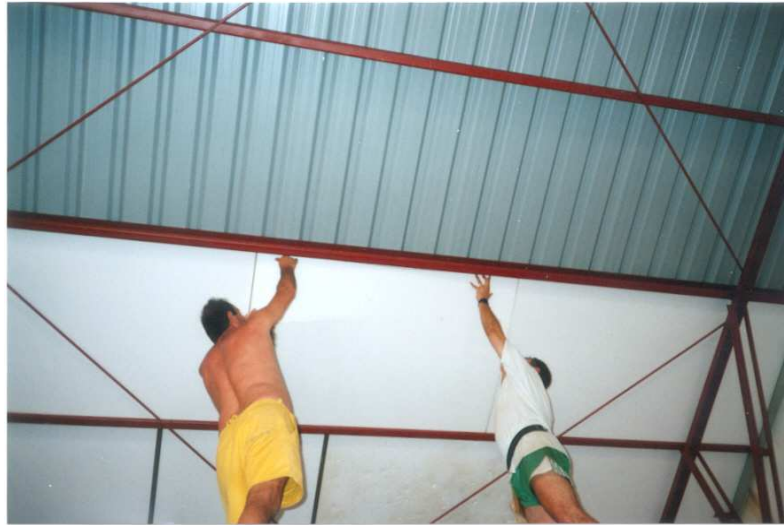
Imagen 5.2.5. Realización de los ajustes oportunos en la colocación de la última plancha de EPS de la fila.
