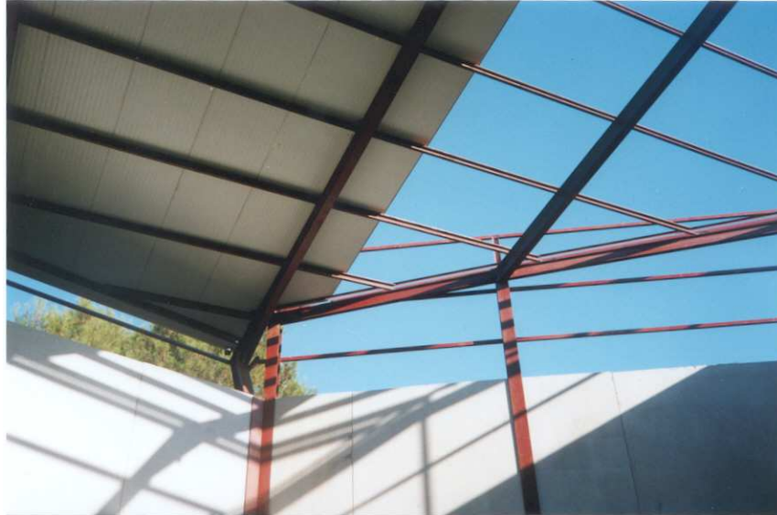
Imagen A.4.11. Ejecución parcial de la cubierta (vista interior).
