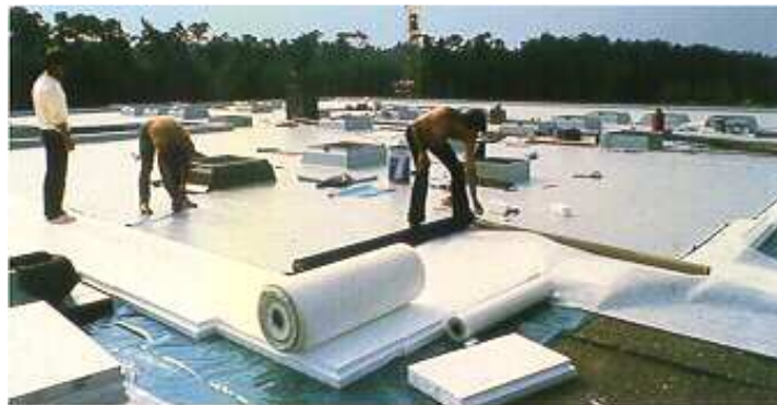
Imagen 5.2.15. Colocación de planchas de EPS en cubierta plana.
