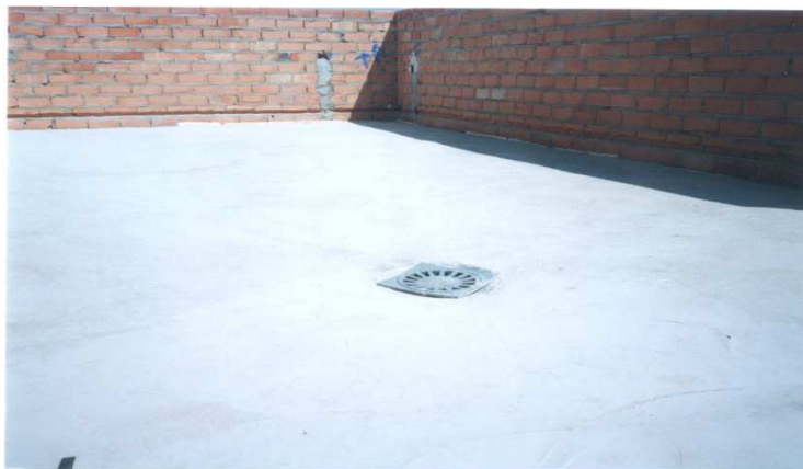
Imagen 5.1.17. Base soporte adecuada para iniciar la ejecución de la cubierta plana invertida.
