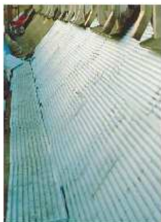
Imágenes 11.3, 11.4, y 11.5 Detalle de la colocación de las planchas de XPS, y de las tejas planas con cordón de mortero, así como el resultado final.
