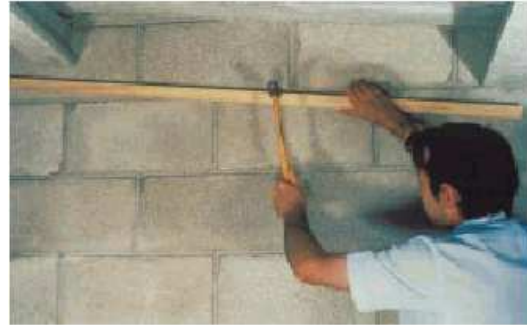
Imagen 5.1.35. Fijación de rastrel de madera a la pared 1 .
