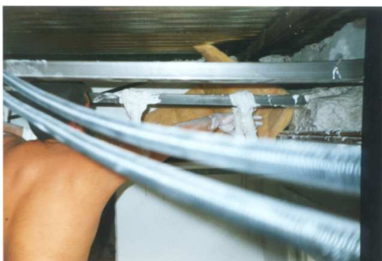
Imagen 5.3.1. Operario colocando la lana de vidrio sobre el techo de placas de yeso.
