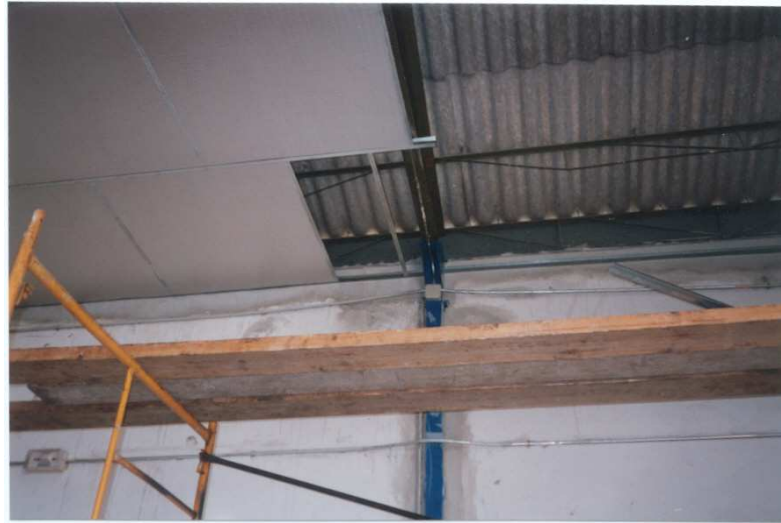
Imagen 5.3.4. Vista del andamio tubular empleado para ejecutar el falso techo. Perfil en C de remate en pared, perfil en I en sentido longitudinal, y perfil en T invertida entre paneles.
