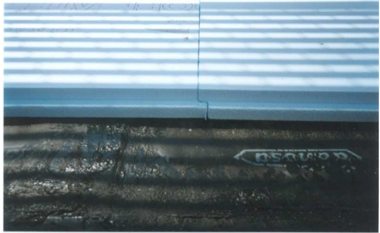
Imagen 5.1.19. Junta a media de madera en las planchas de XPS..
