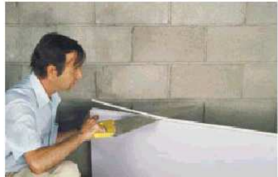
Imagen 5.1.36. Corte del borde longitudinal de la plancha XPS para apoyo del borde recto sobre el rastrel.
