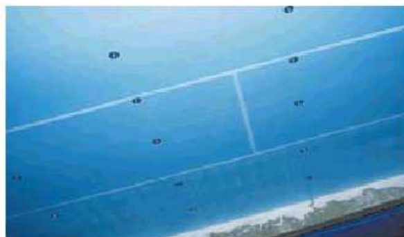
Imagen 5.1.34. Vista del aislamiento bajo correas de cubierta, una vez concluido.
