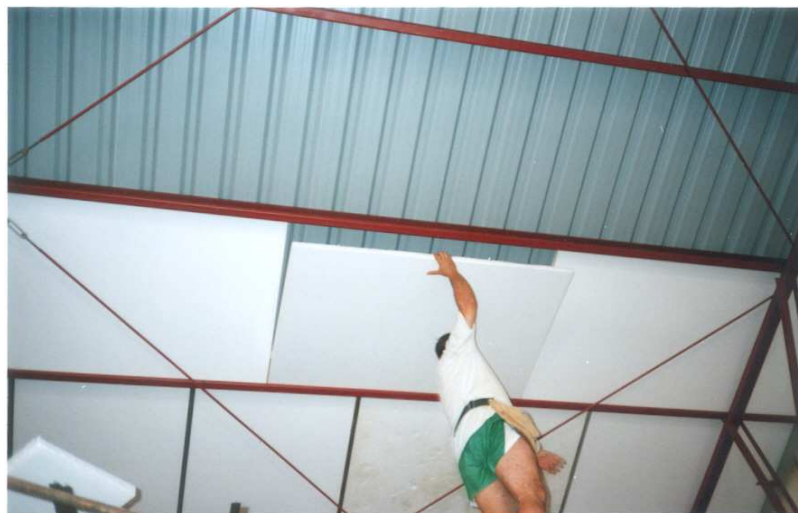
Imagen 5.2.4. Colocación de la última plancha de EPS en una fila.
