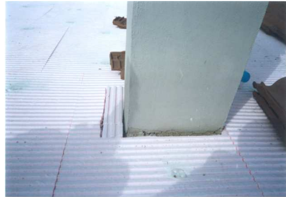
Imagen 5.1.6. Ajuste de las planchas de XPS ante encuentros.
