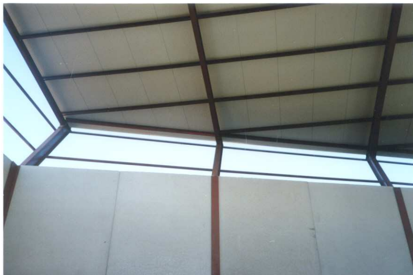
Imagen A.4.10. Vista interior de la nave.
