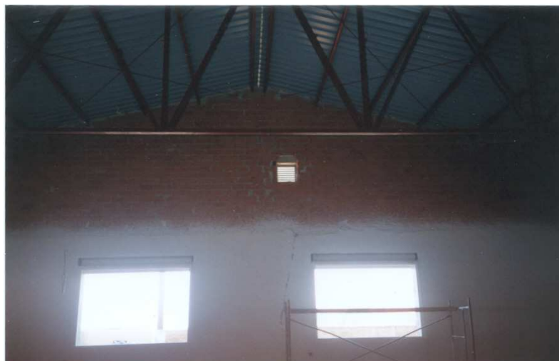
Imagen 5.2.8. Vista de la altura prevista para el falso techo, apreciándose la rejilla de ventilación en fachada.
