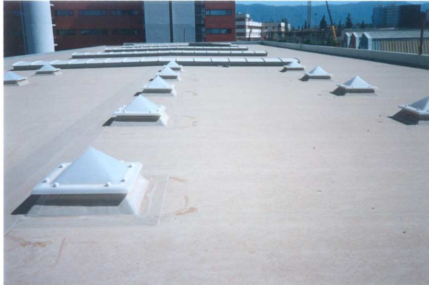
Imagen A.4.3. Vista general de la cubierta.
