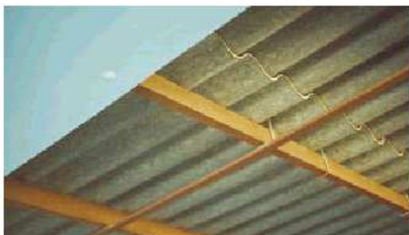
Imagen 5.1.33. Sujeción de planchas de XPS bajo correas de acero.
