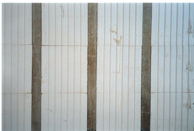
Imagen 5.2.9. Bovedillas de EPS entre viguetas de hormigón. Se aprecian ranuras en la parte inferior para mejorar la adherencia de los revestimientos posteriores.
