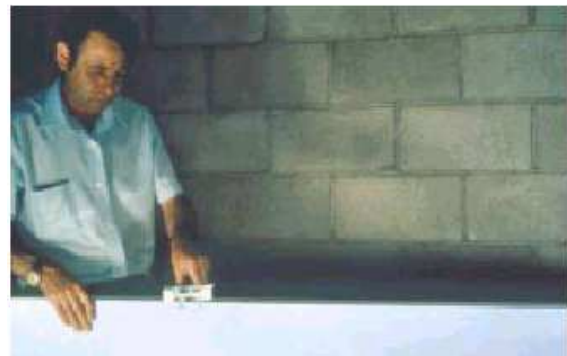
Imagen 5.1.37. Colocación de los clips en la hembra de la plancha XPS.
