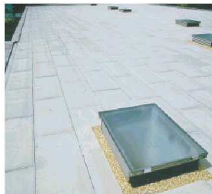
Imagen 5.1.28. Vista general de la cubierta y sus lucernarios 1 .
