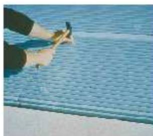
Imágenes 5.1.1. y 5.1.2.- Instalación de planchas de XPS sobre faldones de cubiertas inclinadas 1 .
