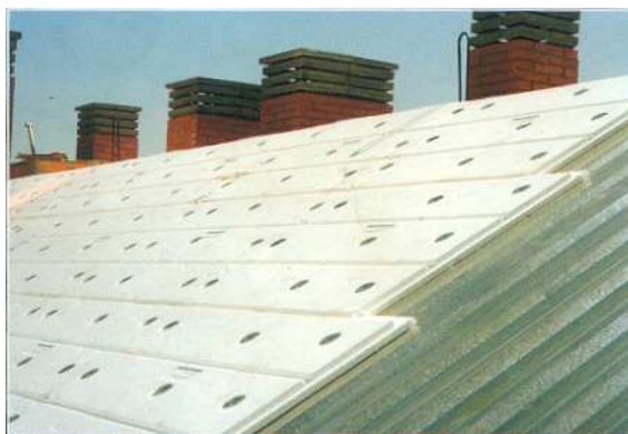
Imagen 5.2.10. Vista de las planchas de EPS con encaje perimetral ya colocadas en cubierta inclinada.
