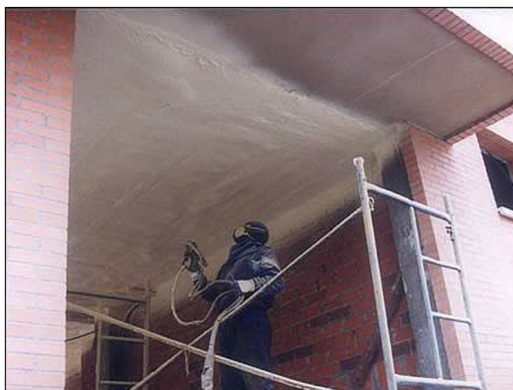
Imagen 5.6.1. Proyección espuma de poliuretano bajo forjado 1 .
