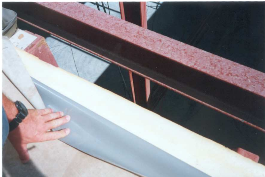
Imagen A.4.6. Vista de la lámina de PVC y alma de poliuretano.
