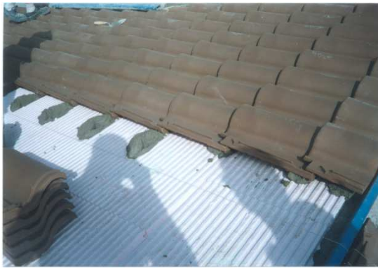
Imágenes 5.1.3. y 5.1.4. - Instalación de planchas de XPS sobre faldones de cubrición de trasteros.
