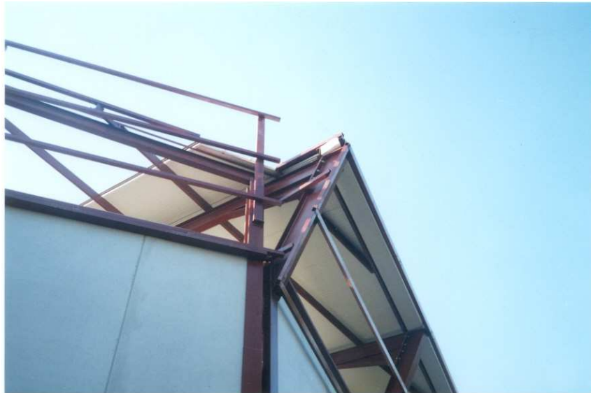
Imagen A.4.9. Los paneles laterales irán inclinados (vista exterior).
