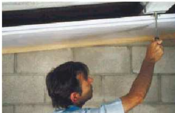
Imagen 5.1.39. Apriete de la abrazadera para su fijación correcta a la vigueta 1 .
