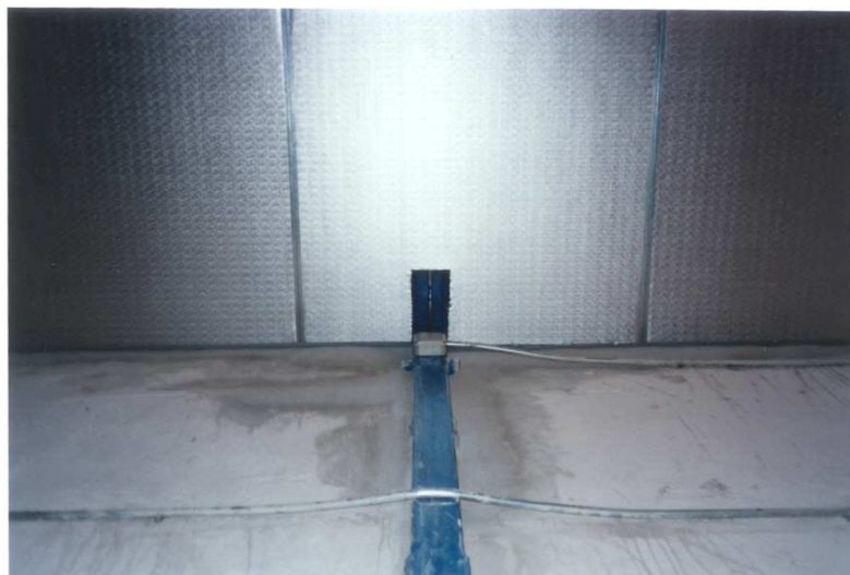
Imagen 5.3.6. Vista del encuentro entre el falso techo y un pilar metálico de la nave. Corte en el panel lo más ajustado posible para evitar puente térmico.
