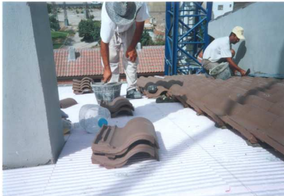
Imagen 5.1.5. Colocación de la teja sobre planchas de XPS.
