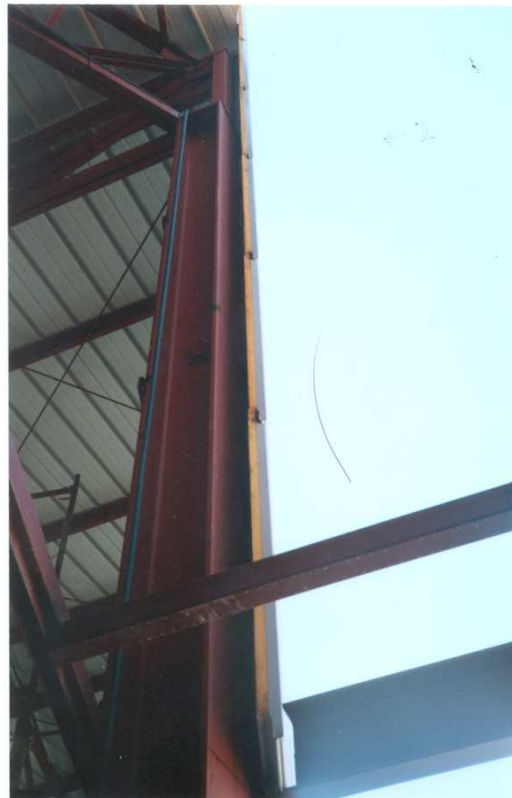
Imagen A.4.8. Vista del panel de fachada.
