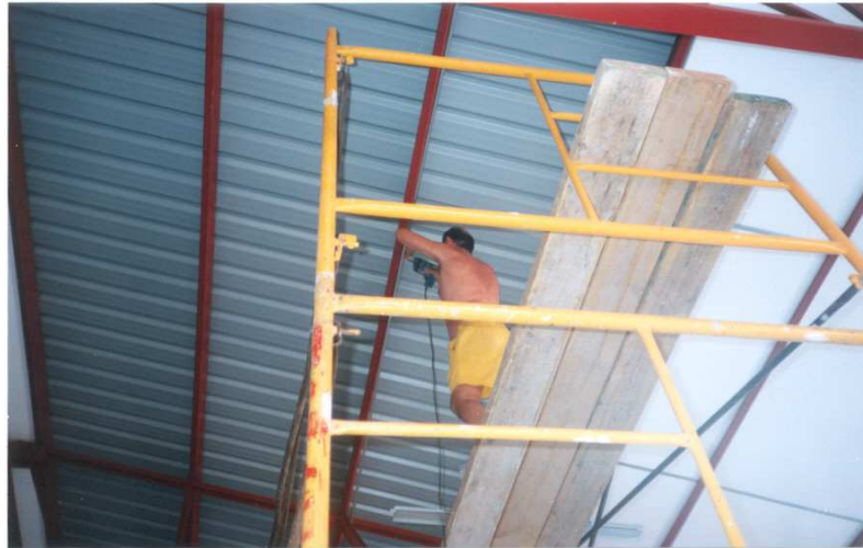
Imagen 5.2.1. Instalación de perfil metálico en C en el lateral de la correa.
