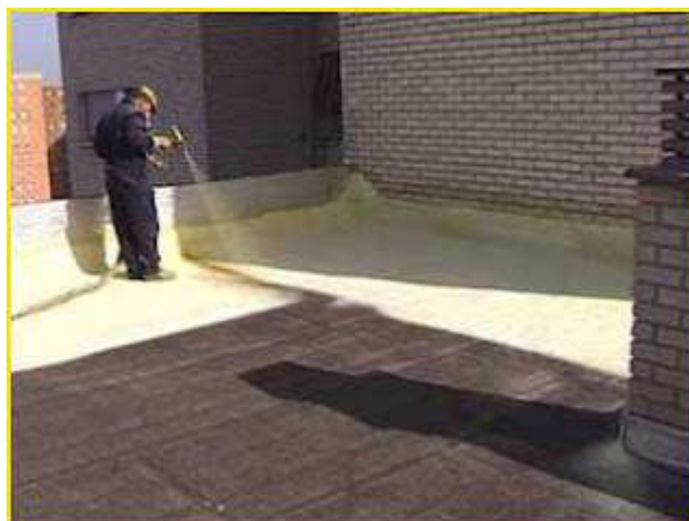
Imagen 5.6.7. Rehabilitación de cubierta plana sobre impermeabilización 1 .
