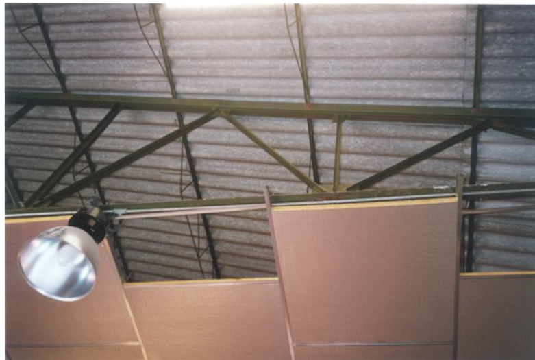
Imagen 5.3.5. Vista del falso techo durante la ejecución. Perfiles en I en sentido longitudinal, sujetos bajo cercha. La cara del panel de papel Kraft aluminio colocada hacia abajo (interior del recinto).
