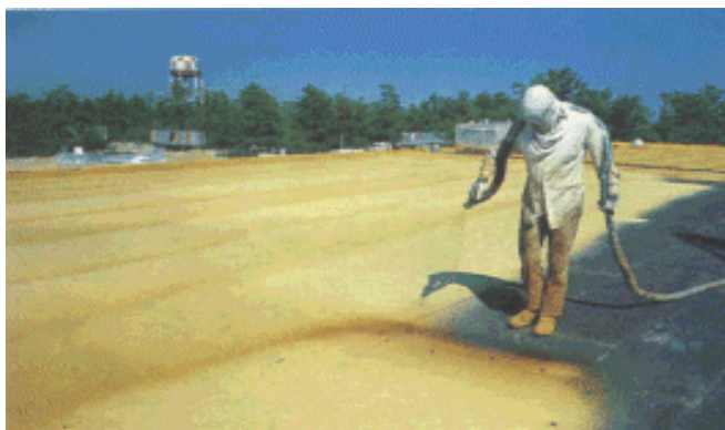
Imagen 5.6.3. Proyección de espuma de poliuretano en cubierta plana 1 .
