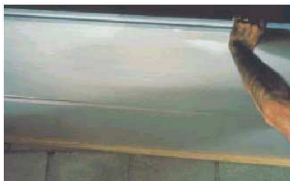
Imagen 5.1.40. Colocación de los clips en la hembra de la plancha XPS 2 .
