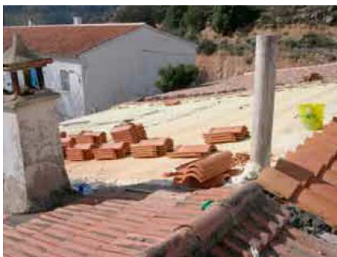
Imagen 5.6.2. Proyección sobre forjado exterior inclinado, bajo teja 1 .
