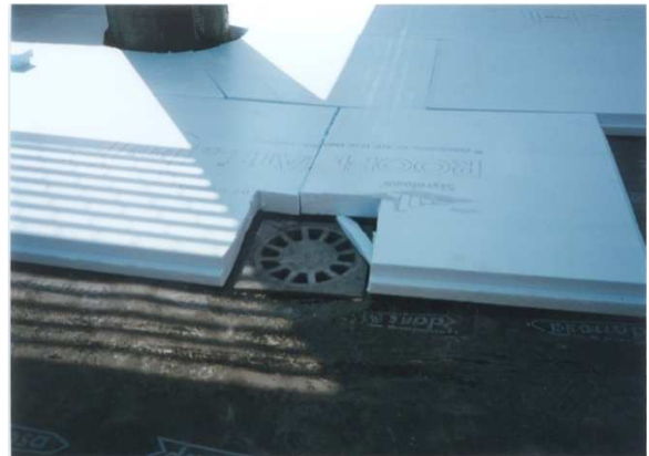
Imagen 5.1.22.. Encuentro de las planchas de XPS con sumidero en cubierta.
