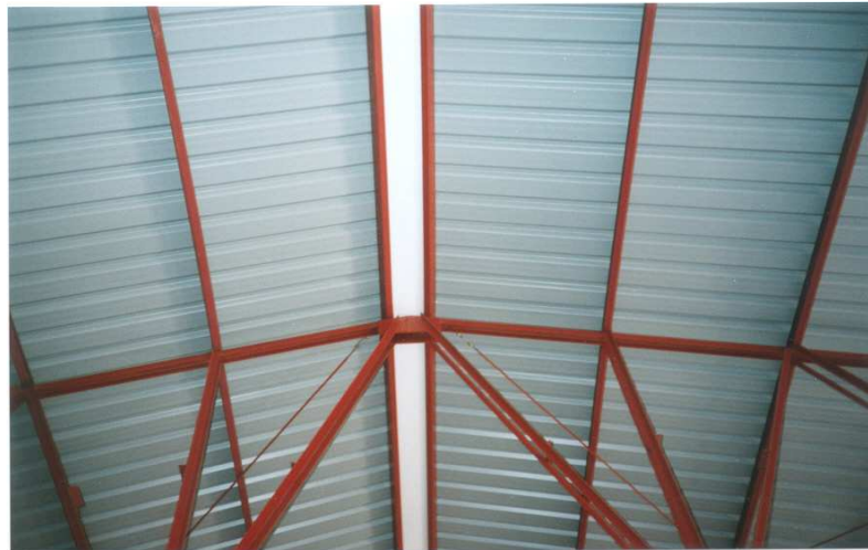
Imagen 5.2.7. Colocación de EPS, cortado a la medida, en puntos como la cumbre (por el interior).
