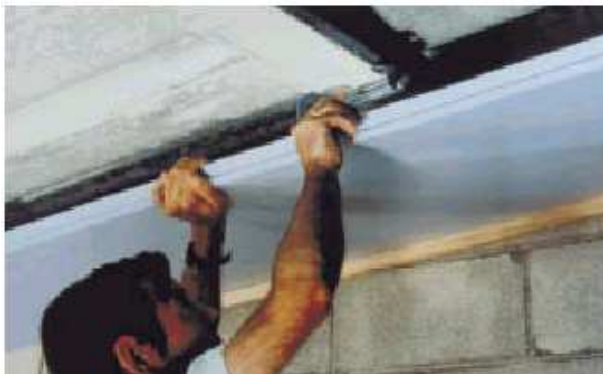
Imagen 5.1.38. Ajuste de la abrazadera sobre la parte inferior de la vigueta.
