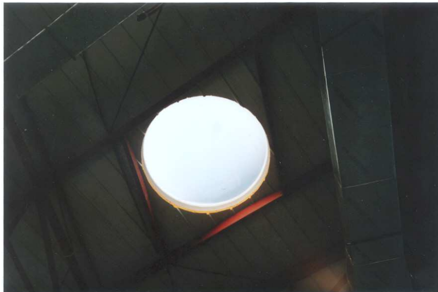
Imagen A.4.2. Claraboya vista desde el interior de la nave.
