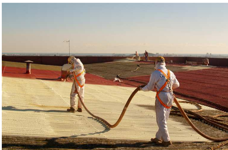
Imagen 5.6.5. Rehabilitación de cubierta por el exterior 1 .
