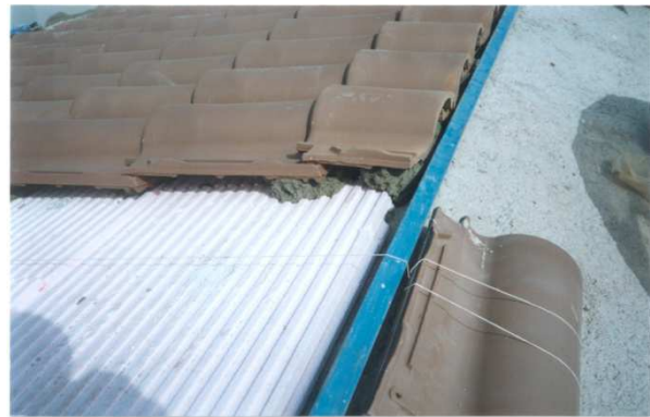
Imágenes 5.1.3. y 5.1.4. - Instalación de planchas de XPS sobre faldones de cubrición de trasteros.
