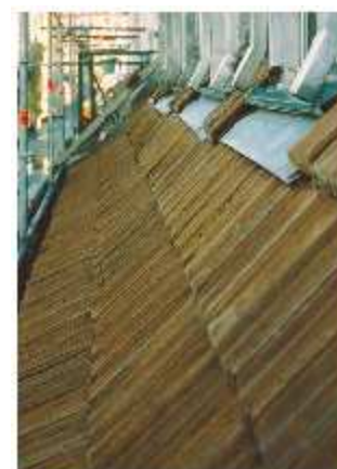
Imágenes 11.3, 11.4, y 11.5 Detalle de la colocación de las planchas de XPS, y de las tejas planas con cordón de mortero, así como el resultado final.
