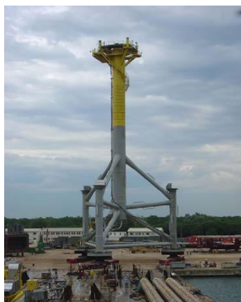
Figura 23. Estructura trípode utilizada por el sector petrolífero.
