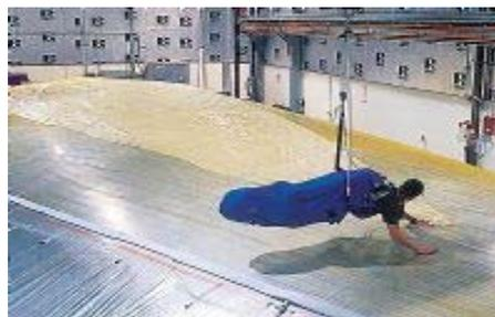
**Ilustración 118: operario colocando film de Mylar.**
