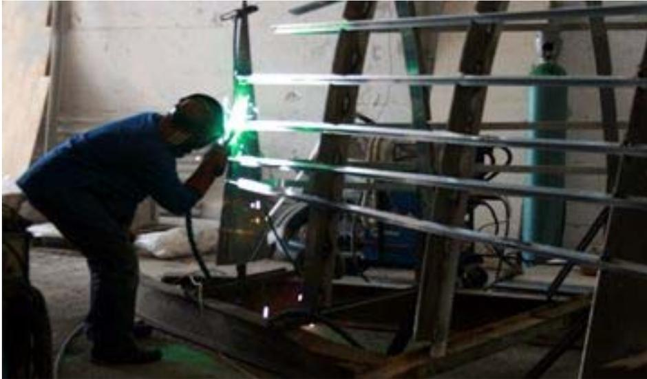
**Ilustración 38: vigas longitudinales.**
