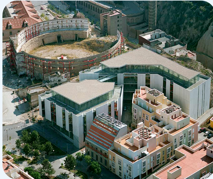
Vista aérea del edificio del ELDI
