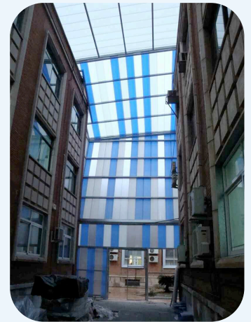
Cubierta del patio de Navales
