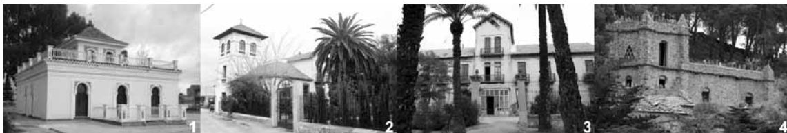
Figura 1. Casa de Diego Pérez Espejo. Figura 2. Villa Pilar. Figura 3. Villa Antonia. Figura 4. Casa del Inglés.
