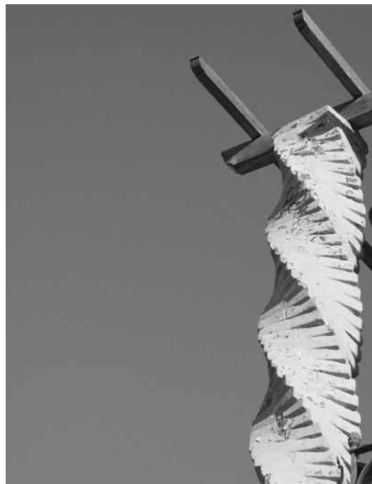
Figura 4. Detalle columna helicoidal de ladrillo.
