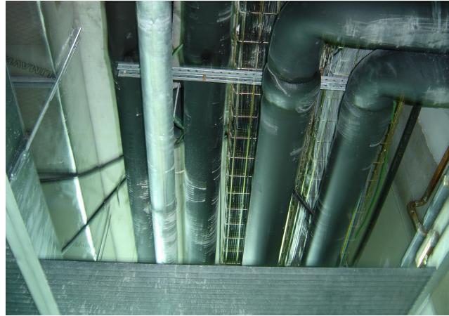
Figura 59: Rejilla e Interiores.
