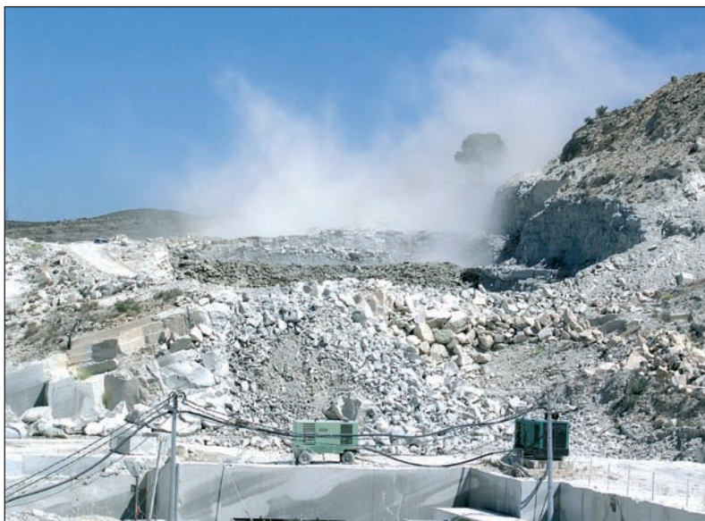
■ [Foto 1].- Resultado de la voladura sobre la zona ornamental.
