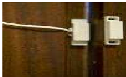
Ilustración 11. Contactador magnético montado en una puerta
