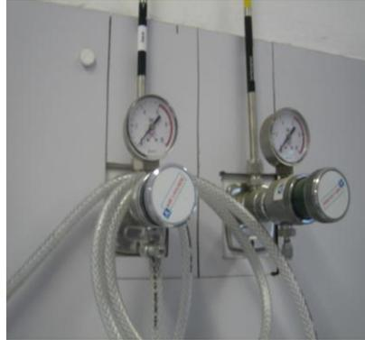
Figura 27: Manómetro que permite ajustar la presión.
