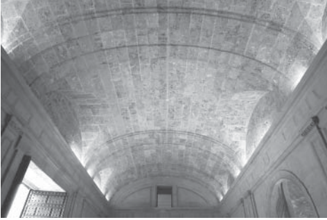
Figura 25. Bóveda de lunetos en el zaguán occidental del Palacio de Carlos V en Granada.
