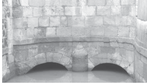
Figura 22. Arcos en torre cavada en los Molinos Nuevos de Murcia.
