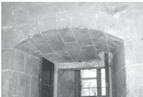
Figura 30. Capialzado desquijado cuadrado en el segundo cuerpo de la torre de la Catedral de Murcia.
