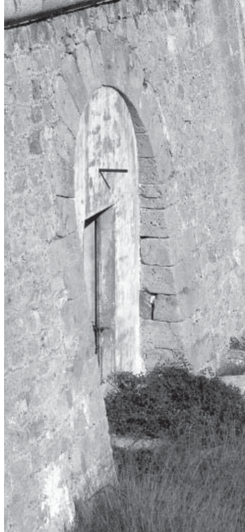
Figura 26. Arco en talud en el castillo de Galeras de Cartagena.
