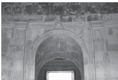
Figura 29. Decenda de cava en el patio del Palacio de Carlos V en Granada.
