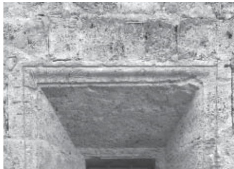
Figura 32. Capialzado a regla monolítico en el Palacio de Carlos V de Granada.
