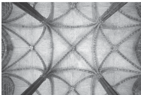
Figura 37. Bóvedas de crucería en el Convento de Predicadores de Valencia, hoy Capitanía General.
