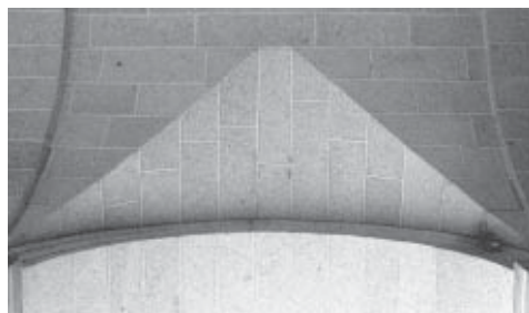
Figura 24. Luneto apuntado y capialzado en el acceso al Patio de los Reyes de El Escorial.
