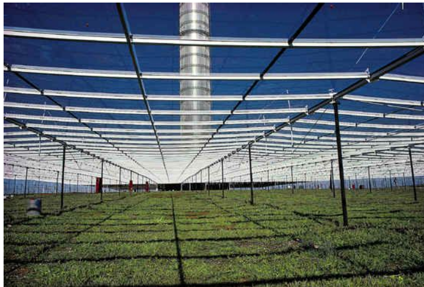
Figura 2.15. Interior del colector solar (Manzanares).
