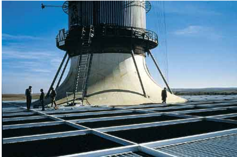
Figura 2.14. Superficie del colector en las cercanías a la chimenea (Manzanares).
