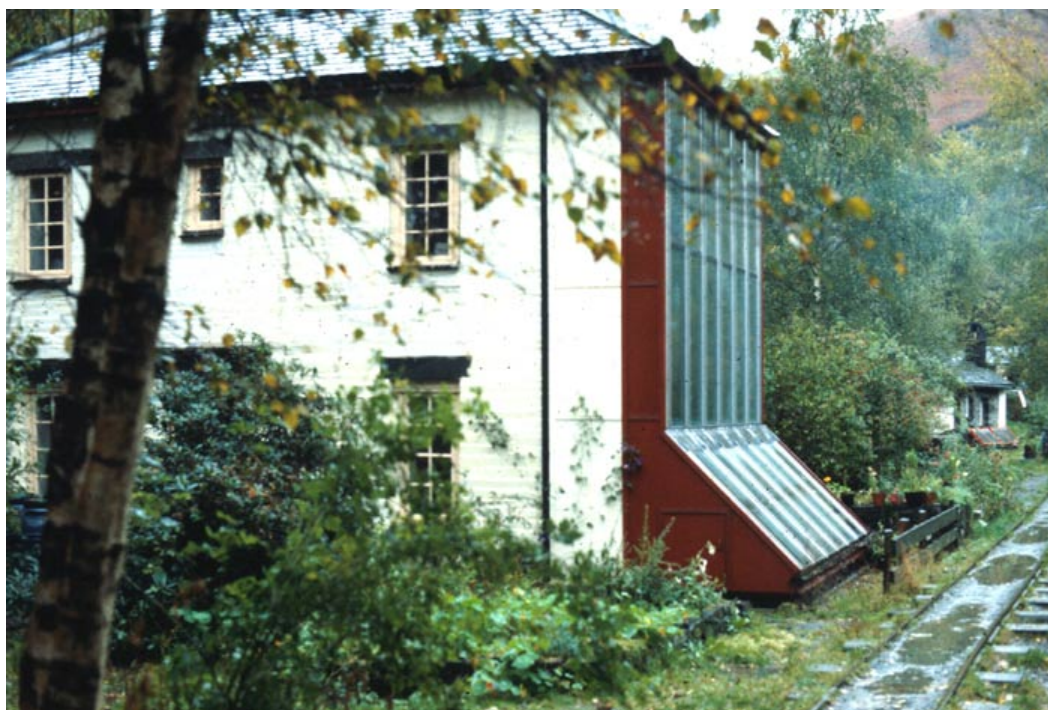
Figura 2.8. Ejemplo real de pared Trombe.
